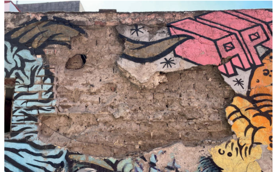
Imagen 27.- Muro en adobe.
