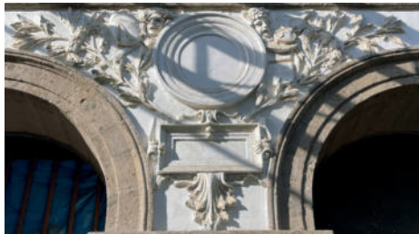
Imagen 35.- Ornamentación de fachada en yeso.
