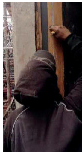
Imágenes 161, 162 y 163.- Aplicación de preservador de madera e hidratación de la madera.
