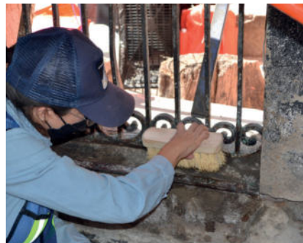
Imágenes 123 y 124.- Limpieza de marcos de ventanas y arco en seco.
