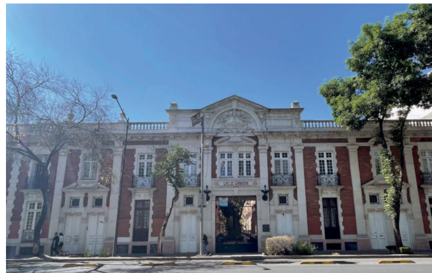
Imagen 18.- Fachada Conjunto Mascota sobre calle Bucareli.
