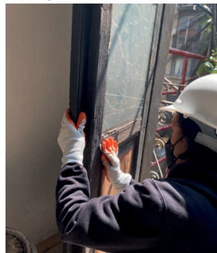
Imágenes 159 y 160.- Lijado de superficie y aplicación de insecticida.
