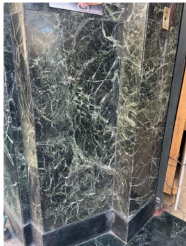
Imagen 26.- Placa de mármol en recubrimiento de muros y rodapié.
