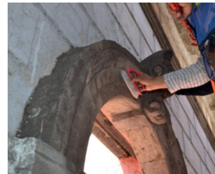
Imágenes 123 y 124.- Limpieza de marcos de ventanas y arco en seco.
