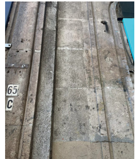
Imagen 23.- Cantera en vano de acceso.
