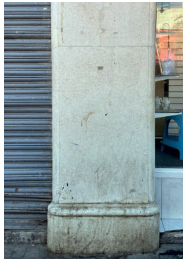
Imagen 30.- Pilastras en granito artificial.
