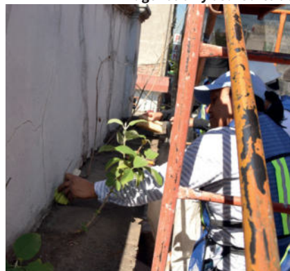
Imágenes 94 y 95.- Aplicación de alcohol hasta saturar.
