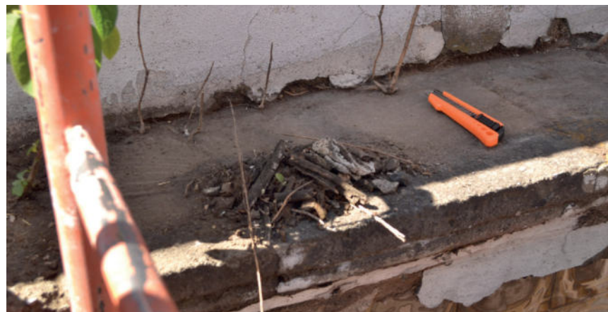
Imagen 100.- Acopio de material producto de la limpieza.
