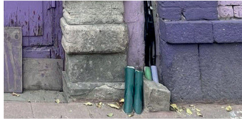
Imagen 79.- Erosión mecánica
