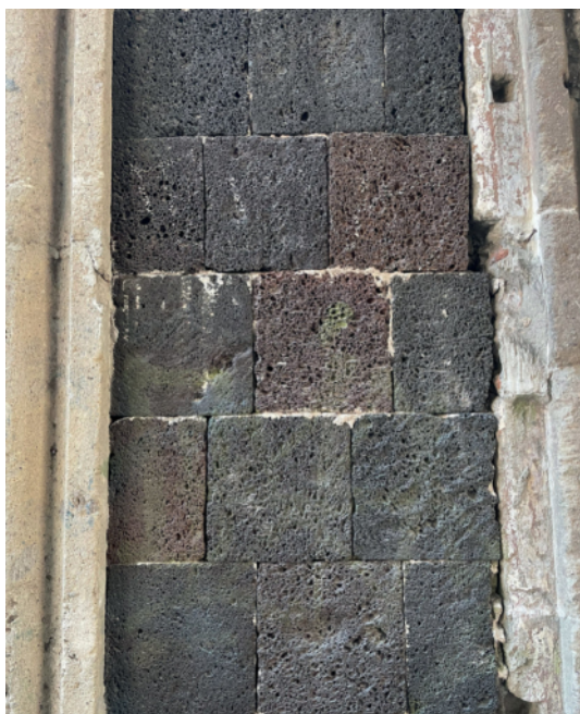
Imagen 24.- Tezontle laminado en muro de fachada.
