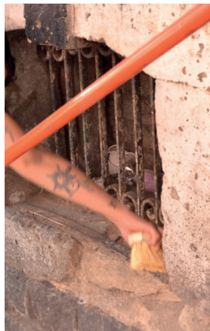
Imágenes 128 y 129.- Limpieza de elementos en seco y aplicación de desengrasante.
