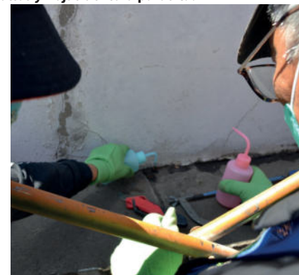
Imágenes 94 y 95.- Aplicación de alcohol hasta saturar.
