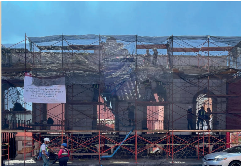
Imagen 5.- Caso de estudio. Fachada en calle Alarcón 17.
