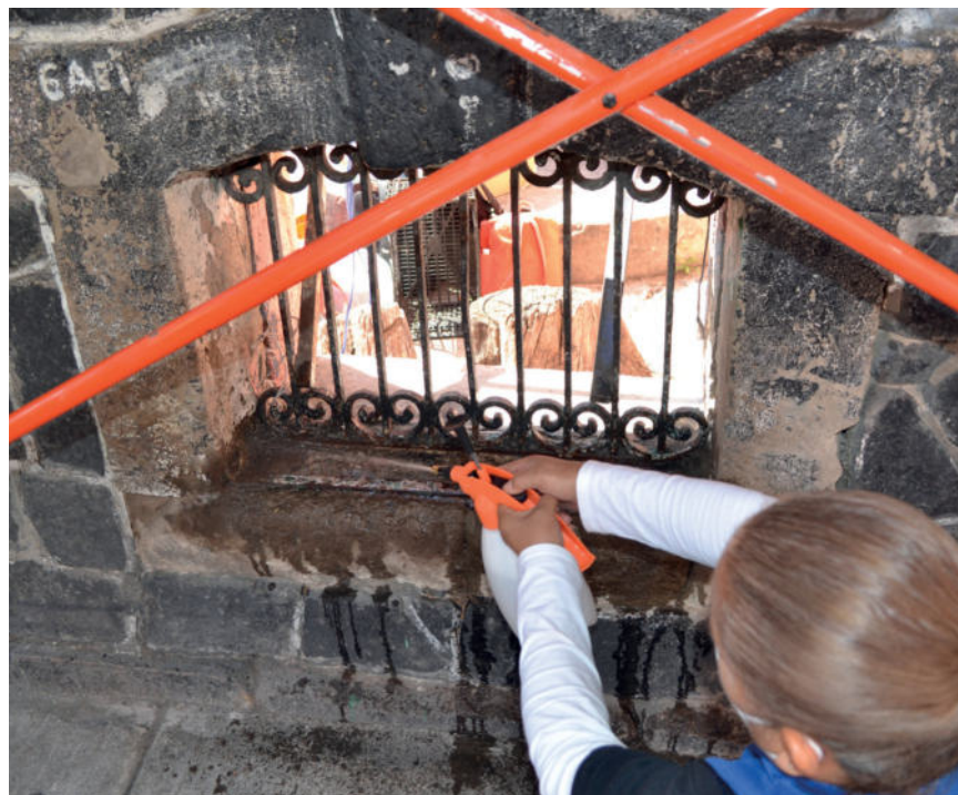
Imagen 127.- Retiro de solución acuosa con agua a presión.
