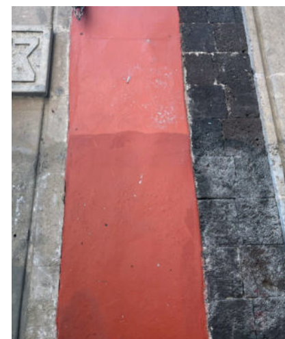
Imagen 33.- Diferencias entre pintura a la cal aplicada sobre muro y pintura vinílica.
