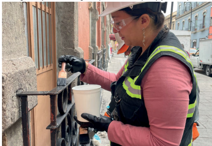
Imagen 146.- Aplicación de ácido tánico sobre elementos de herrería.
