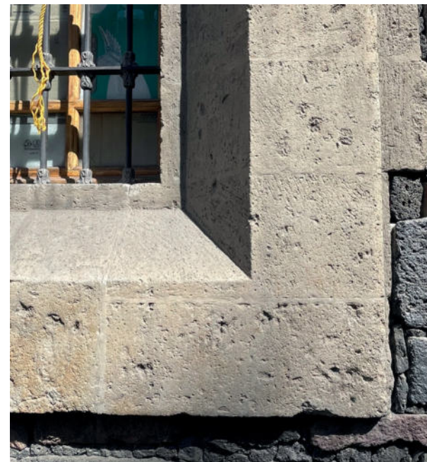
Imagen 20.- Uso de roca chiluca para enmarcamientos.
