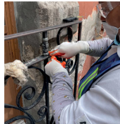
Imágenes 144 y 145.- Retiro de segunda capa de esmalte con espátula y lijado de la superficie.
