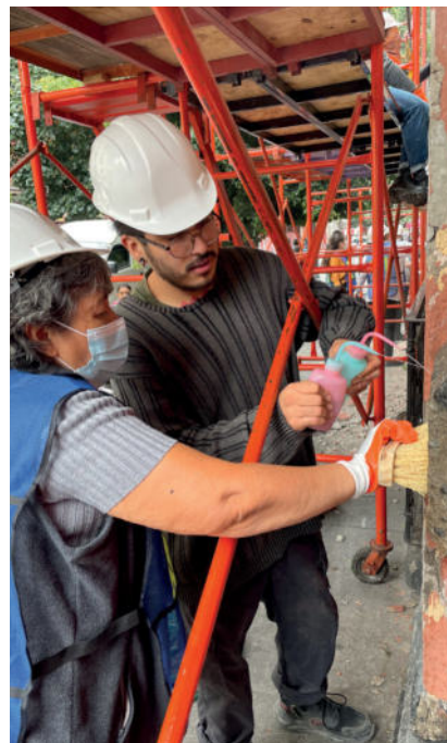
Imágenes 130 y 131.- Aplicación de desengrasante y retiro con agua a presión.
