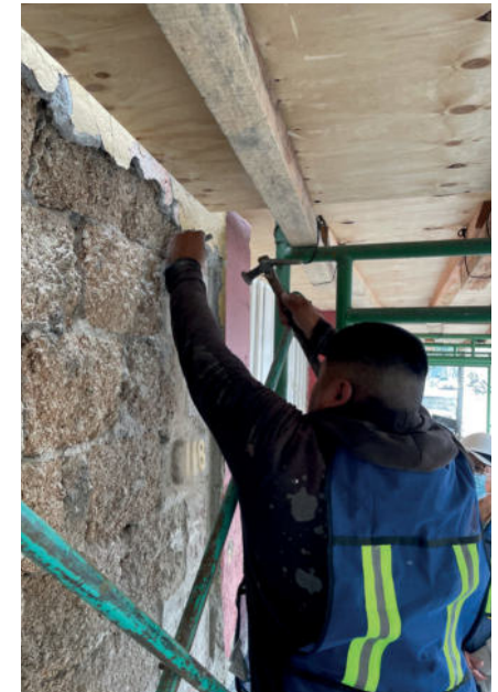
Imágenes 166 y 167.- Retiro de soporte fuera de uso con herramienta menor.
