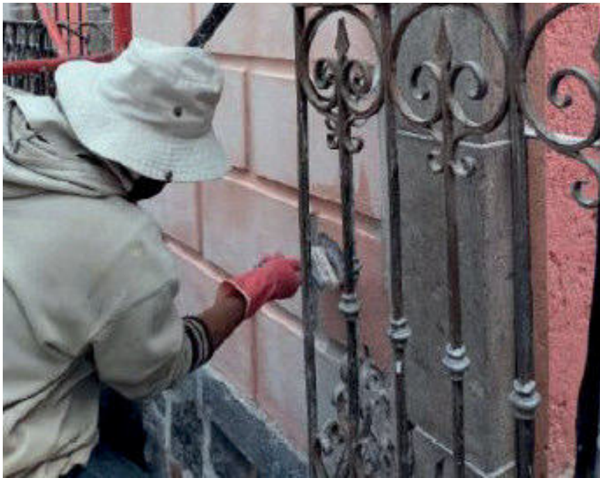
Imagen 13.- Detalle de trabajos de obra menor.
