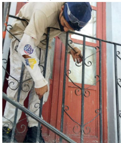
Imágenes 153 y 154.- Lijado de superficie y aplicación de primario anticorrosivo. Fuente: Fideicomiso Centro Histórico
