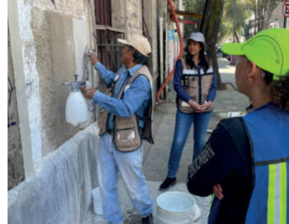
Imágenes 114 y 115.- Hidratación en el área donde se aplicará la pintura a la cal.
