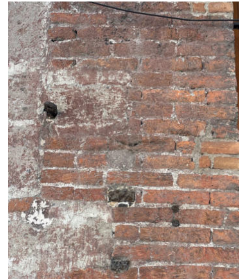
Imagen 29.- Muro en tabique aparente.
