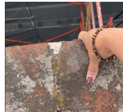
Imágenes 108 y 109.- Estado de tapa de pretil y verificación de estado de conservación.
