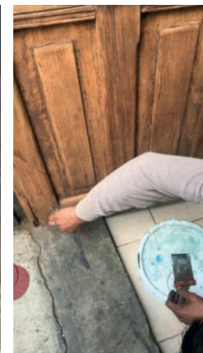
Imágenes 161, 162 y 163.- Aplicación de preservador de madera e hidratación de la madera.
