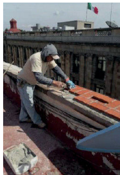
Imágenes 112 y 113.- Colocación de ladrillo sobre tapa de pretil.
