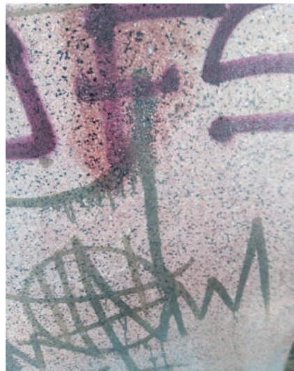
Imágenes 132 y 133.- Aplicación de removedor especial sobre pintas vandálicas.
