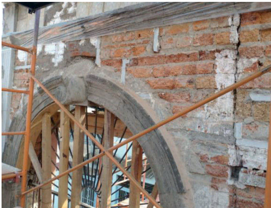
Imagen 11.- Detalle de trabajos de Obra Mayor.
