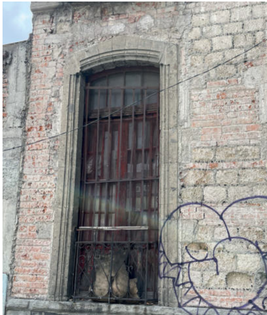
Imagen 28.- Muro con sillares de tepetate.
