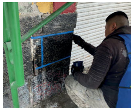
Imágenes 135 y 136.- Aplicación de removedor especial sobre pintura vinílica en elementos pétreos.
