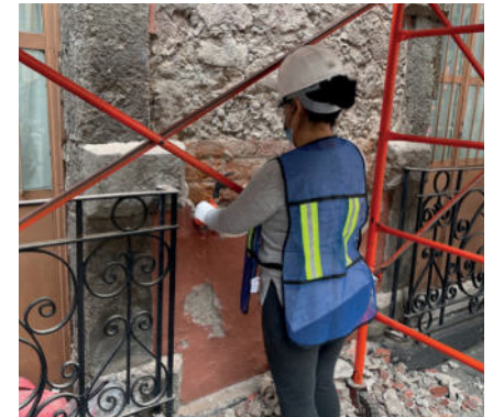
Imágenes 104 y 105.- Retiro de aplanados en planta baja y planta alta.
