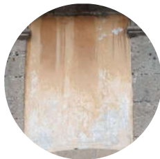
Aplanado Cal- arena
