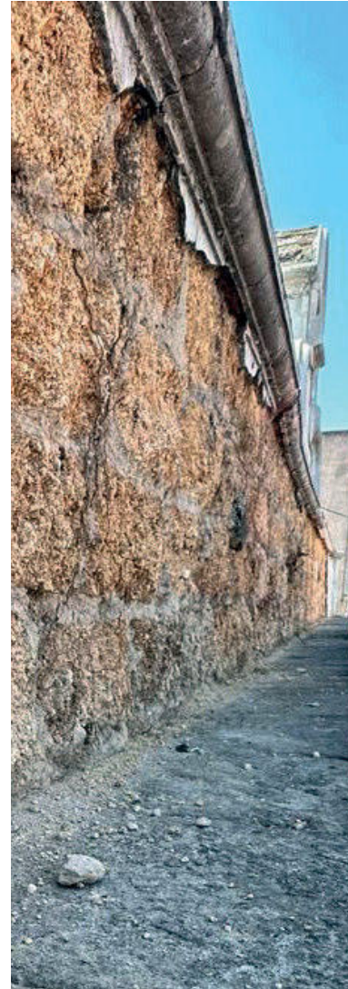
Imagen 88.- Disgregación muro de tepetate. Fuente: Fideicomiso Centro Histórico.
