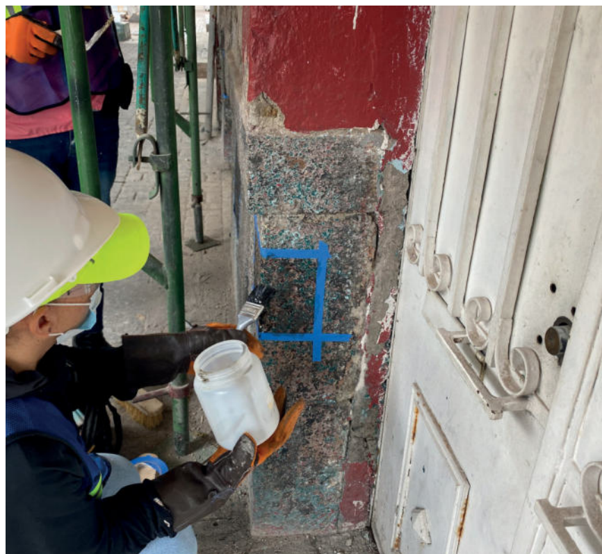
Imagen 134.- Aplicación de removedor especial sobre engobes.
