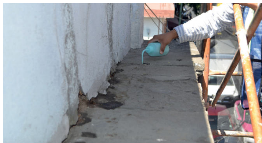
Imagen 101.- Aplicación de solución preparada en zonas engrosadas.
