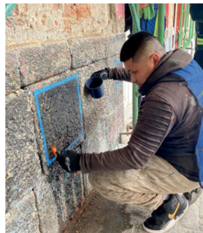
Imágenes 139 y 140.- Aplicación de agua caliente sobre rodapié.
