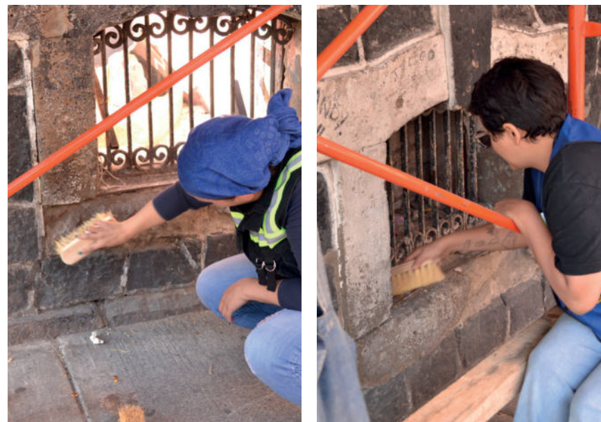
Imágenes 120 y 121.- Limpieza de marcos de ventanas.
