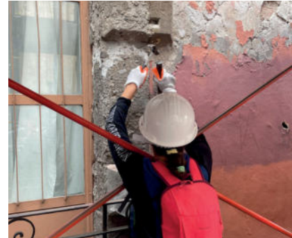
Imágenes 102 y 103.- Retiro de aplanados en planta baja de fachada.
