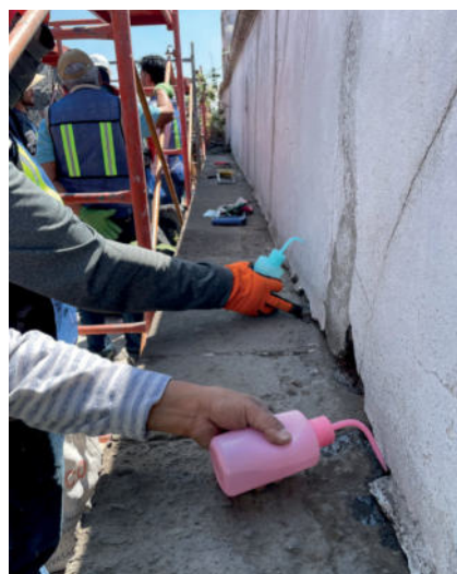
Imágenes 96 y 97.- Aplicación de agua oxigenada hasta saturar.
