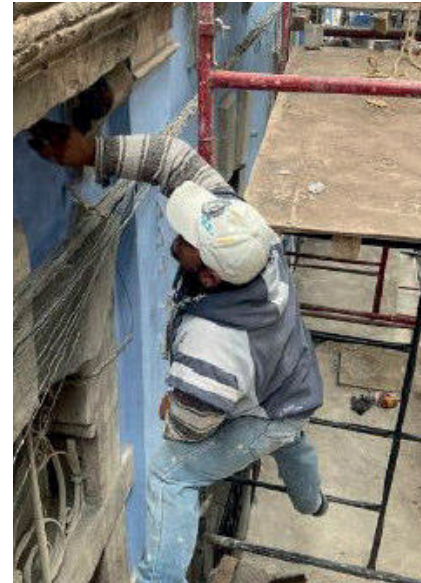
Imágenes 118 y 119.- Aplicación de pintura a la cal.
