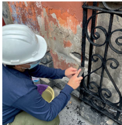
Imágenes 144 y 145.- Retiro de segunda capa de esmalte con espátula y lijado de la superficie.
