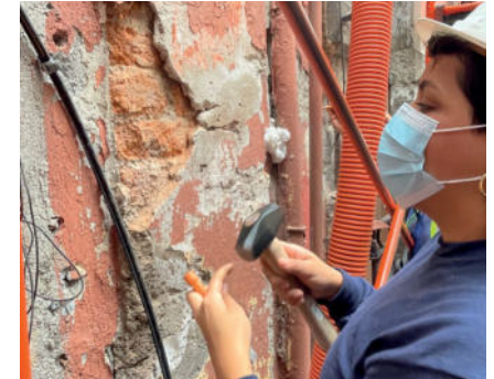
Imágenes 102 y 103.- Retiro de aplanados en planta baja de fachada.
