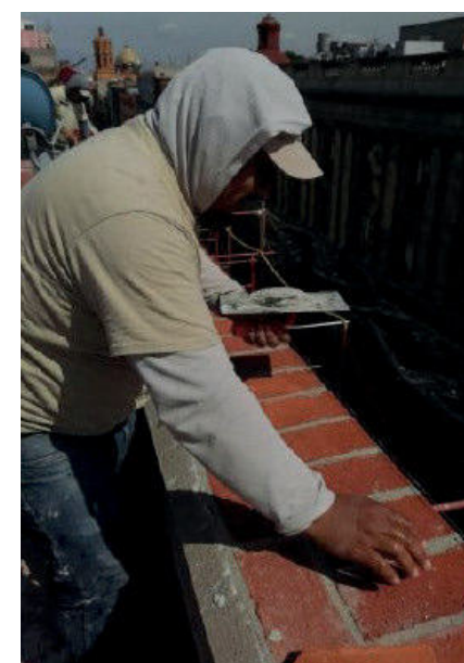
Imágenes 112 y 113.- Colocación de ladrillo sobre tapa de pretil.
