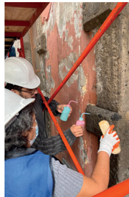
Imágenes 128 y 129.- Limpieza de elementos en seco y aplicación de desengrasante.
