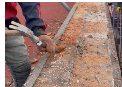
Imágenes 110 y 111.- Retiro de ladrillos sueltos con herramienta menor.
