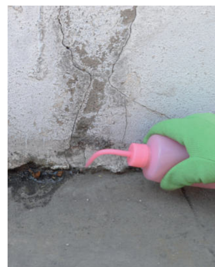
Imágenes 96 y 97.- Aplicación de agua oxigenada hasta saturar.
