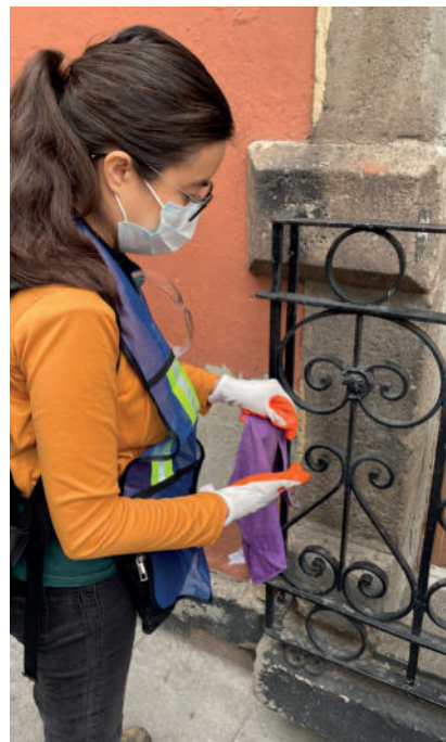
Imágenes 149 y 150.- Limpieza de elementos de herrería.
