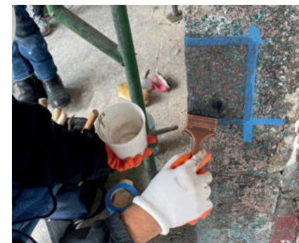
Imágenes 135 y 136.- Aplicación de removedor especial sobre pintura vinílica en elementos pétreos.
