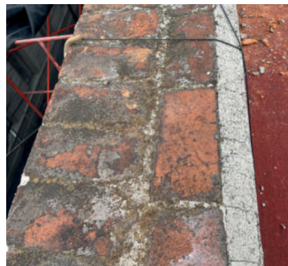
Imágenes 108 y 109.- Estado de tapa de pretil y verificación de estado de conservación.
