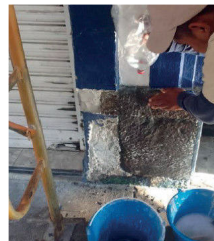
Imágenes 139 y 140.- Aplicación de agua caliente sobre rodapié.
