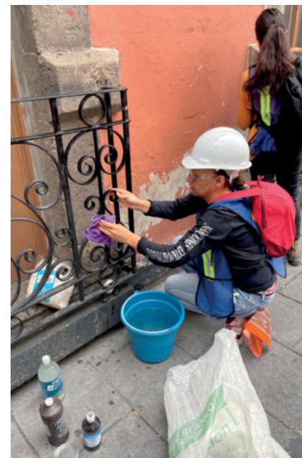
Imágenes 147 y 148.- Limpieza de elementos de herrería.
