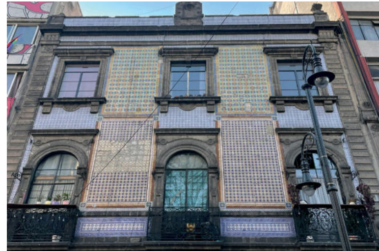
Imagen 31.- Muro con recubrimiento tipo talavera.
