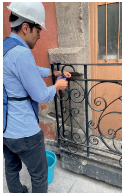
Imágenes 147 y 148.- Limpieza de elementos de herrería.
