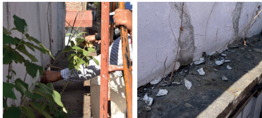
Imágenes 98 y 99.- Retiro con herramienta menor de líquenes.
