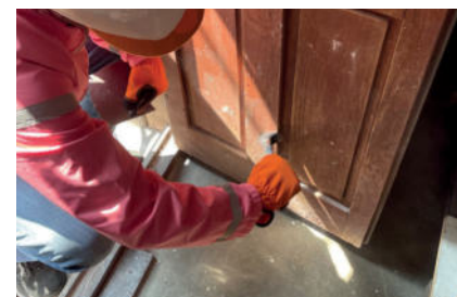
Imágenes 157 y 158.- Revisión de estado de conservación y limpieza de puertas de madera.
