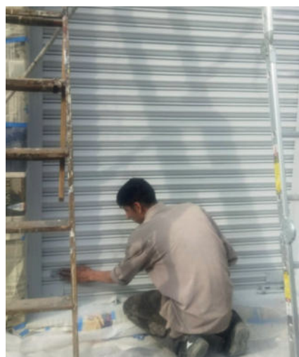
Imágenes 155 y 156.- Limpieza de puerta con lija y desengrasante y aplicación de esmalte alquidálico. Fuente: Fideicomiso Centro Histórico
