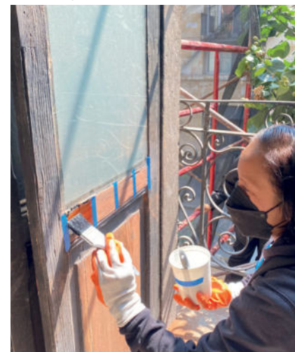
Imágenes 159 y 160.- Lijado de superficie y aplicación de insecticida.
