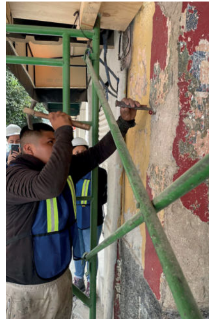
Imágenes 166 y 167.- Retiro de soporte fuera de uso con herramienta menor.
