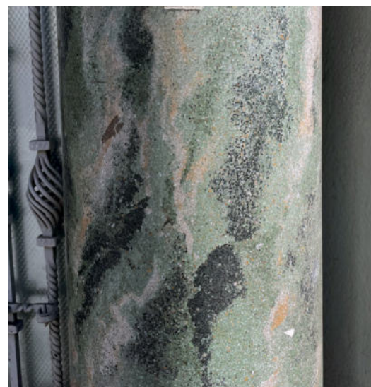
Imagen 25.- Granito natural en pilastra de acceso principal.
