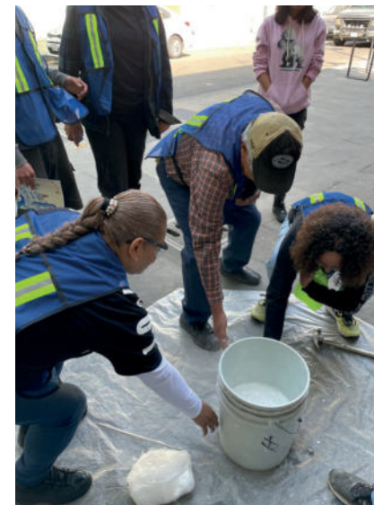
Imagen 32.- Proceso de apagado de cal.
