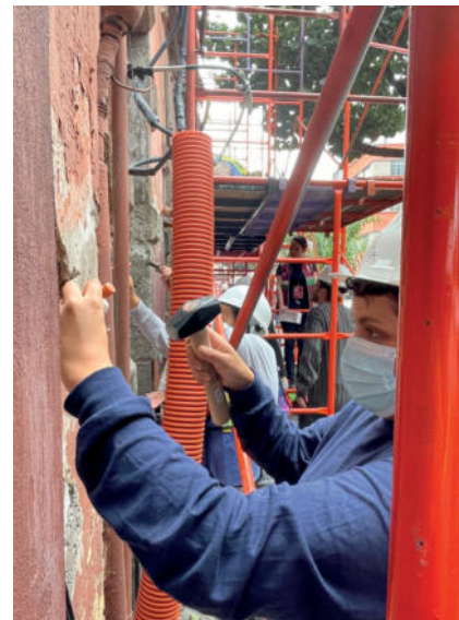
Imágenes 106 y 107.- Herramienta utilizada y limpieza de áreas que presentan disgregación.
