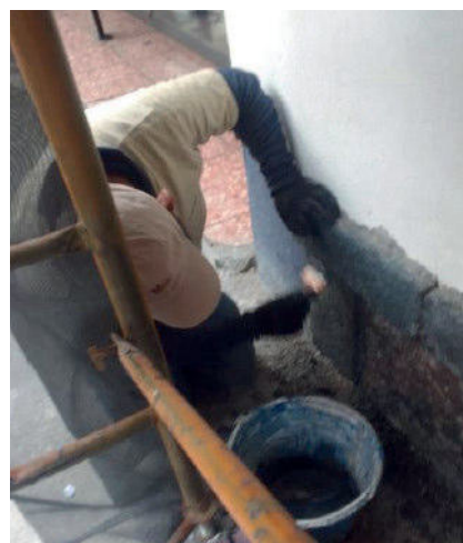
Imágenes 137 y 138.- Aplicación de removedor especial sobre pintura vinílica en elementos pétreos.
