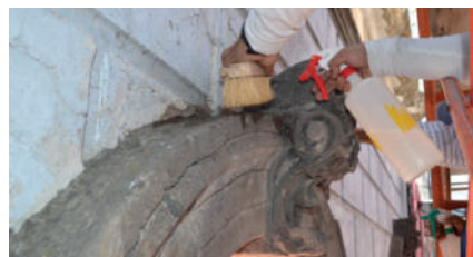
Imágenes 125 y 126.- Limpieza de marcos de ventanas y arco con solución acuosa.
