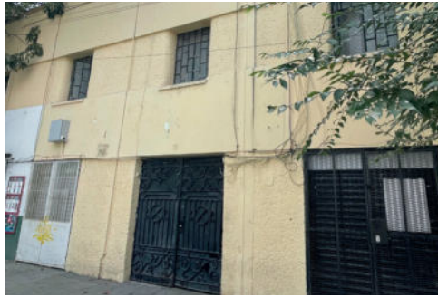
Imagen 34.- Fachada con aplanado de cemento-arena.
