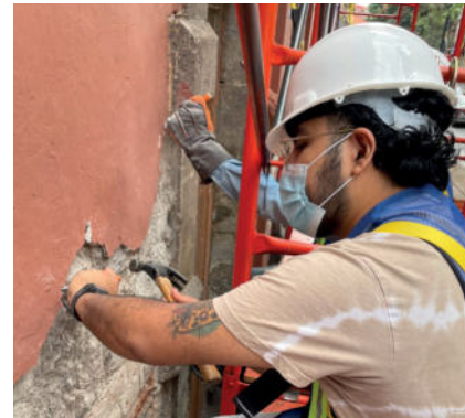
Imágenes 104 y 105.- Retiro de aplanados en planta baja y planta alta.
