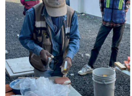
Imágenes 114 y 115.- Hidratación en el área donde se aplicará la pintura a la cal.
