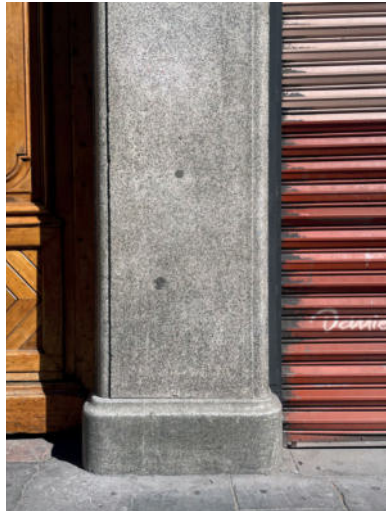
Imagen 30.- Pilastras en granito artificial.
