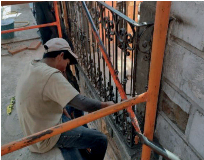
Imagen 14.- Detalle de trabajos de obra menor.
