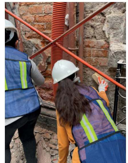
Imágenes 106 y 107.- Herramienta utilizada y limpieza de áreas que presentan disgregación.
