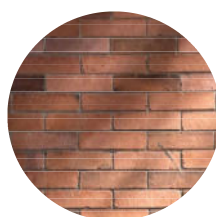
Muros de ladrillo rojo
