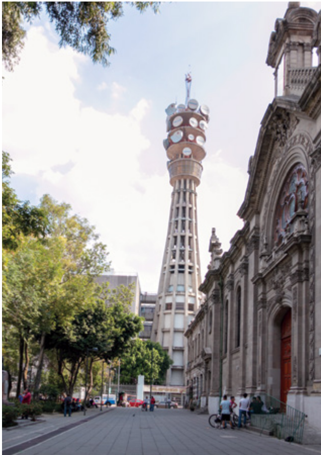
• Vista de la Plaza de San Juan con el edificio de Teléfonos de México al fondo.
