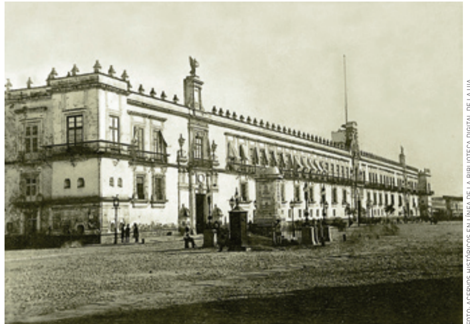
PALACIO NACIONAL ENTRE 1877 Y 1881. EL OBELISCO A ENRICO MARTÍNEZ, EN CONSTRUCCIÓN
