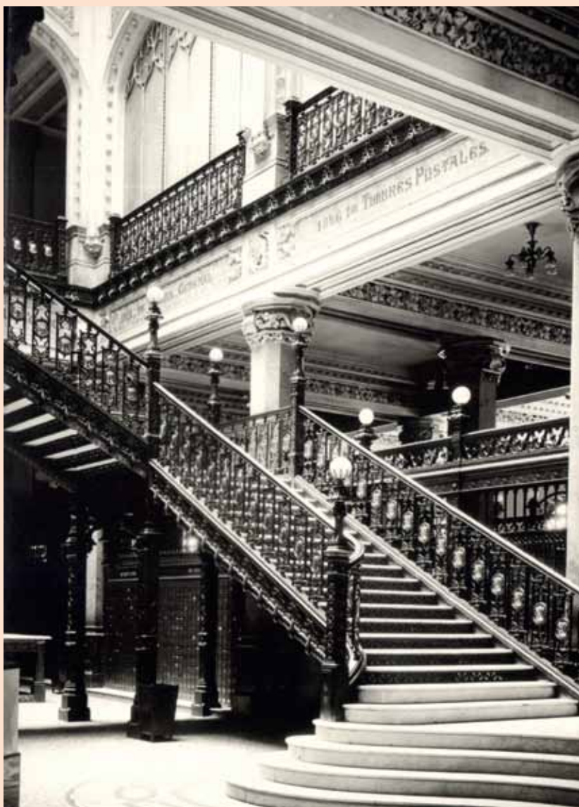
INTERIOR DEL PALACIO POSTAL. EL EDIFICIO FUE INAUGURADO EN 1907.
