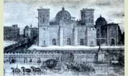
LAS TORRES, EN CONSTRUCCIÓN.
