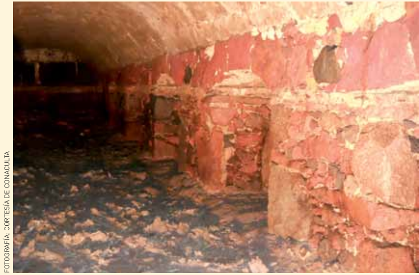
EL SISTEMA DE BÓVEDAS MIDE ENTRE 90CM Y 180CM DE ALTO.
