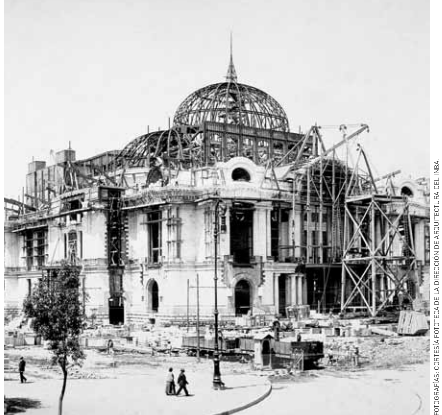
EL PALACIO DE BELLAS ARTES EN CONSTRUCCIÓN (1910).
