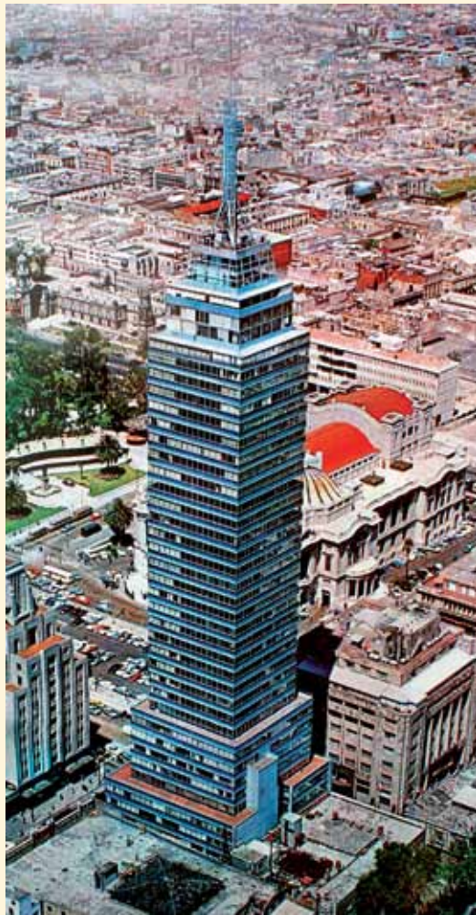
PRIMER RASCACIELOS EN TERRENO DE ALTO RIESGO.
