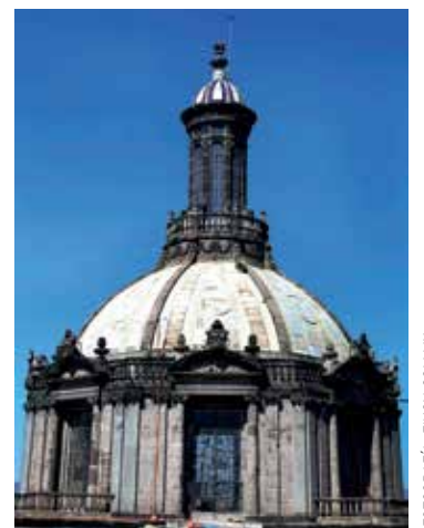
LA CÚPULA, OBRA DE TOLSÁ.
