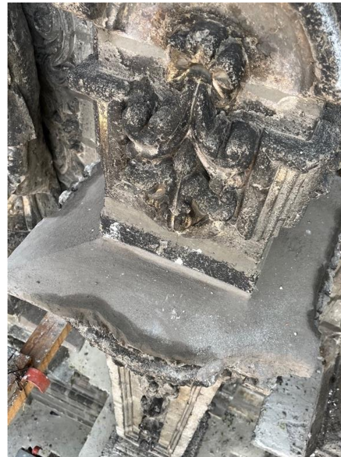
Figura 42. Integración de chaflanes en fachada principal
