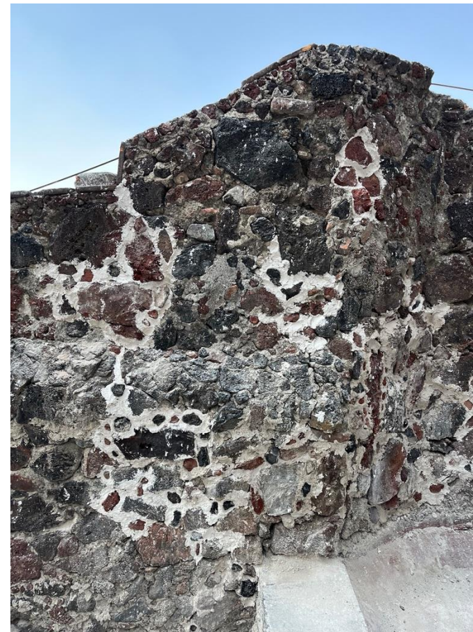
Figura 128. Acabado final en paramentos de azotea
