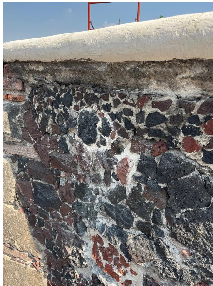
Figura 186. Resultados del proceso de remamposteo, rejunteo e integración de cornisa
