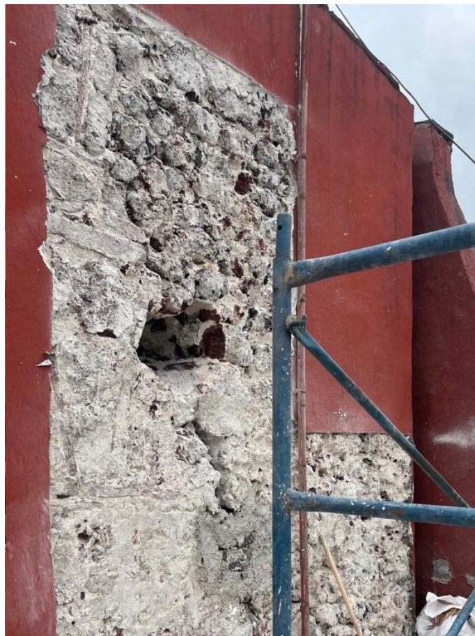
Figura 145. Proceso de consolidación en muro poniente
