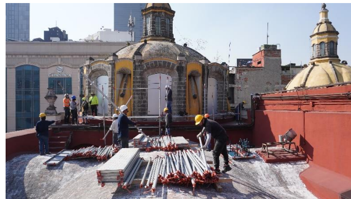
Figura 45. Instalación de andamio multidireccional..
