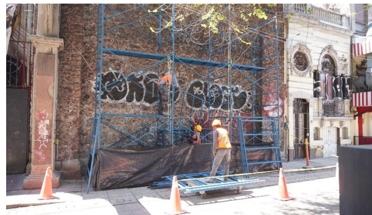
Figura 96. Armado de andamio.
