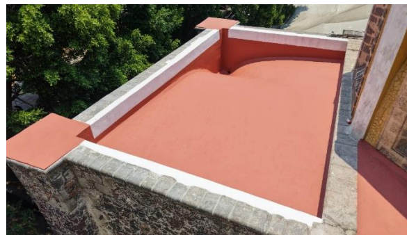
Figura 87. Estado final de extradós bóveda Capilla de Dolores.
