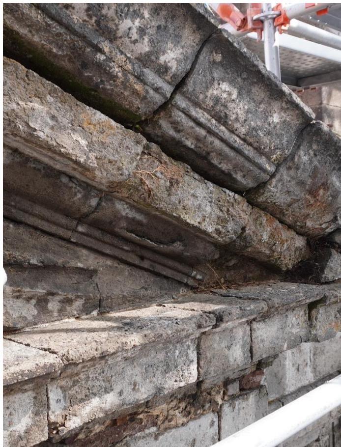
Figura 78. Estado del frontón previo a su intervención
