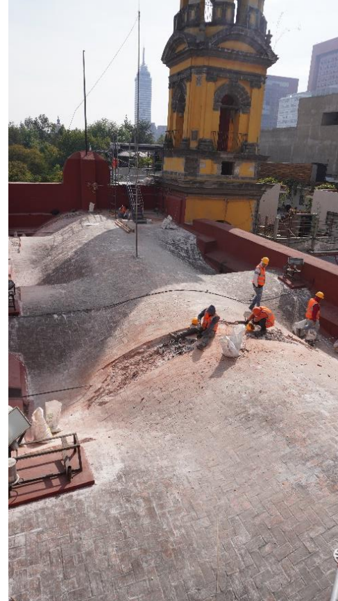
Figura 4. Liberación de enladrillado en trayectoria de grietas.
