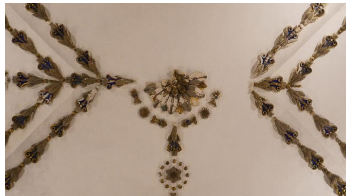
Figura 82 .Estado final de intradós de bóveda de Capilla de Dolores.
