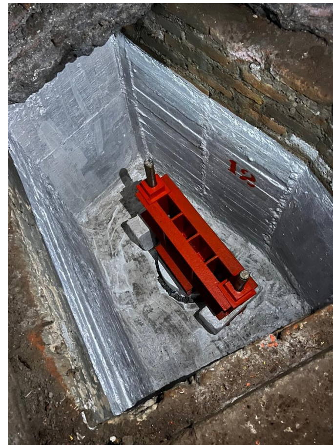
Figura 165. Pilote 12 tras intervención
