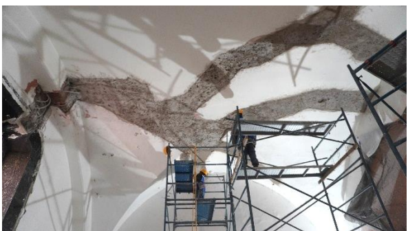
Figura 39. Aplanado en áreas intervenidas grietas de intradós de bóveda del Coro.
