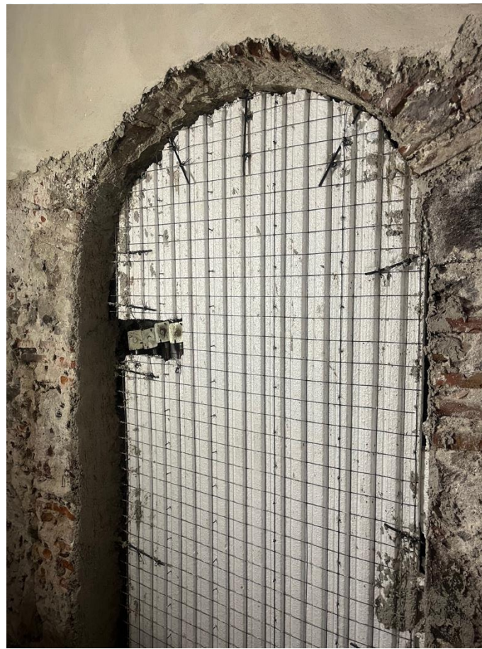
Figura 171. Proceso de cierre de muro
