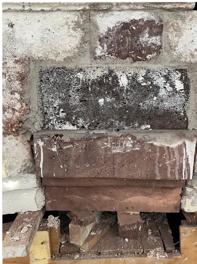
Figura 108. Proceso de intervención de dovela en arco toral
