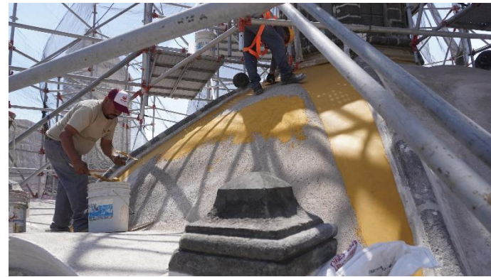
Figura 55. Reintegración de pintura a la cal.
