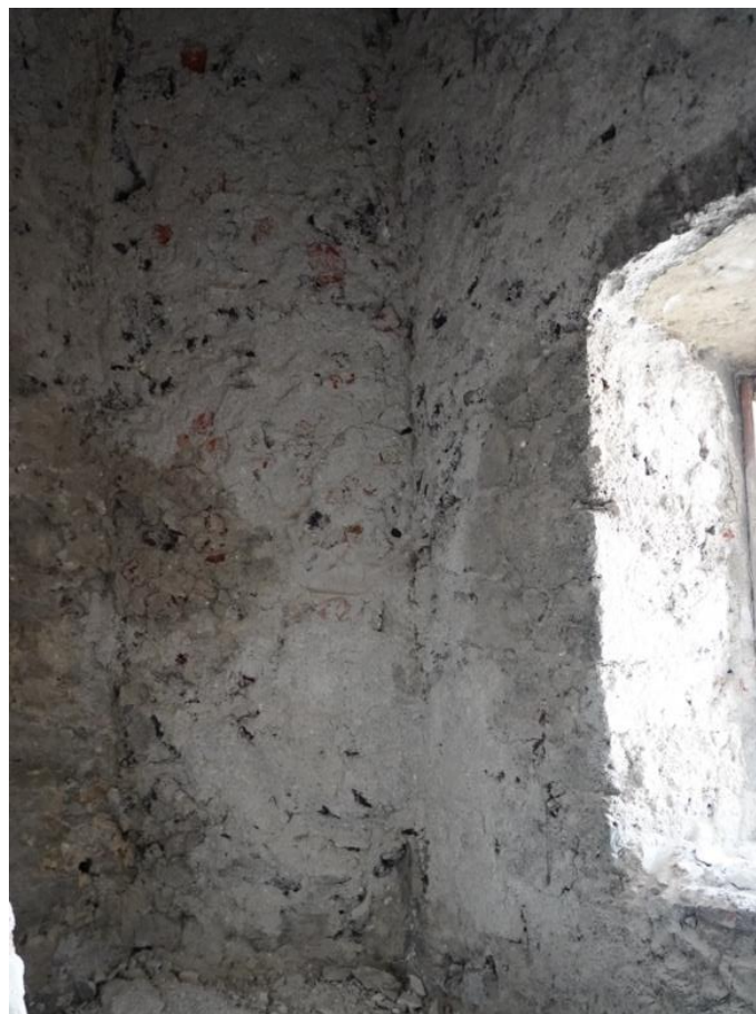
Figura 26. Proceso de intervención en paramentos interiores de la torre
