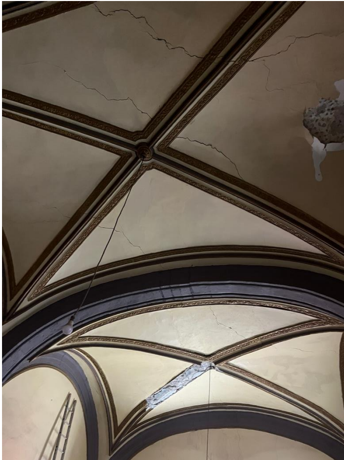
Figura 68. Estado del intradós de bóvedas en sacristía
