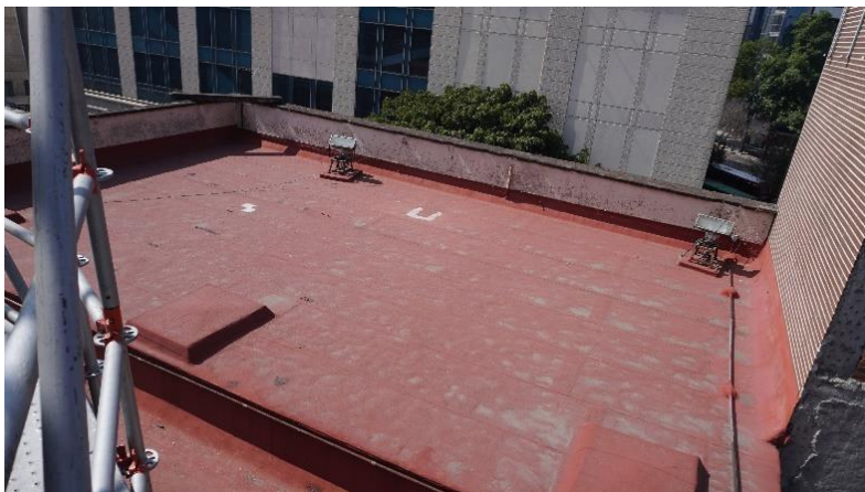
Figura 17. Estado inicial de cubiertas.
