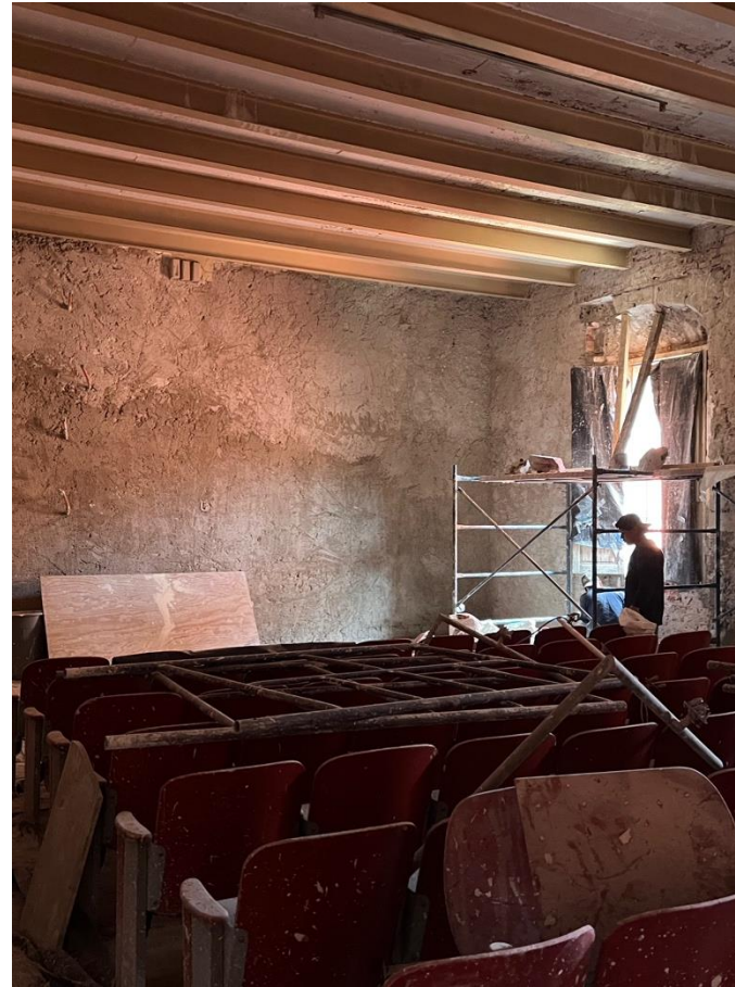
Figura 60. Proceso de intervención en auditorio
