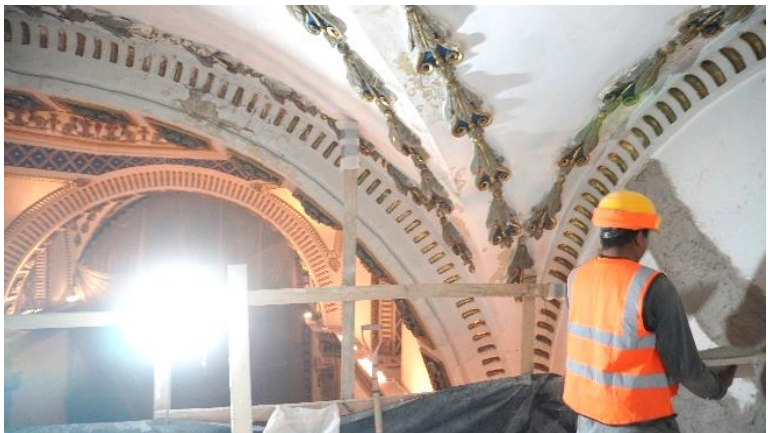
Figura 79. Reintegración de aplanados en bóveda de la Capilla de Dolores.
