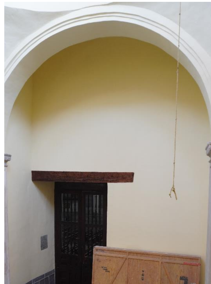
Figura 109. Acabado final en dovela de arco toral
