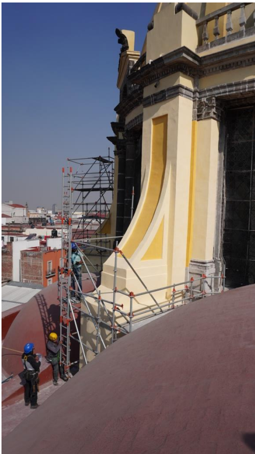
Figura 133. Retiro de andamios en contrafuertes
