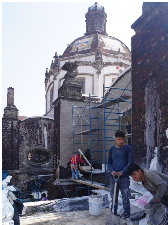
Figura 50. Proceso de intervención en fachada norte
