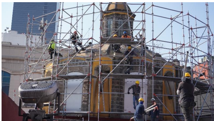
Figura 46. Instalación de andamio multidireccional.
