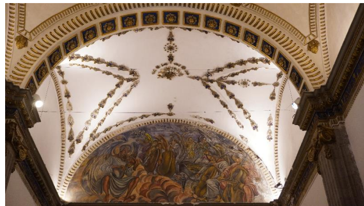
Figura 84 .Estado final de intradós de bóveda de Capilla de Dolores.
