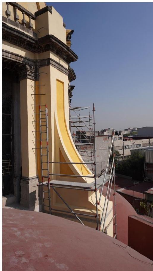
Figura 134. Retiro de andamios en contrafuertes
