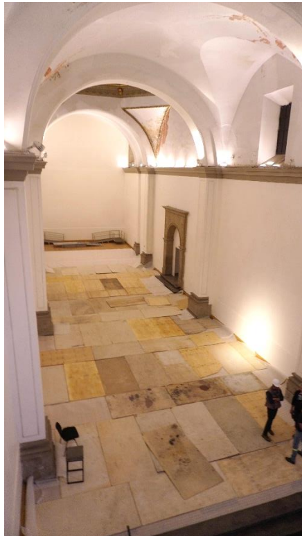
Figura 22. Protección de piso en Nave Principal.
