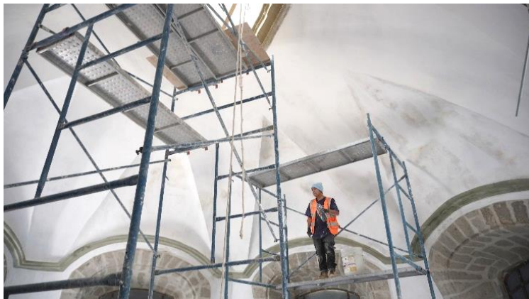
Figura 66. Reintegración de pintura a la cal.
