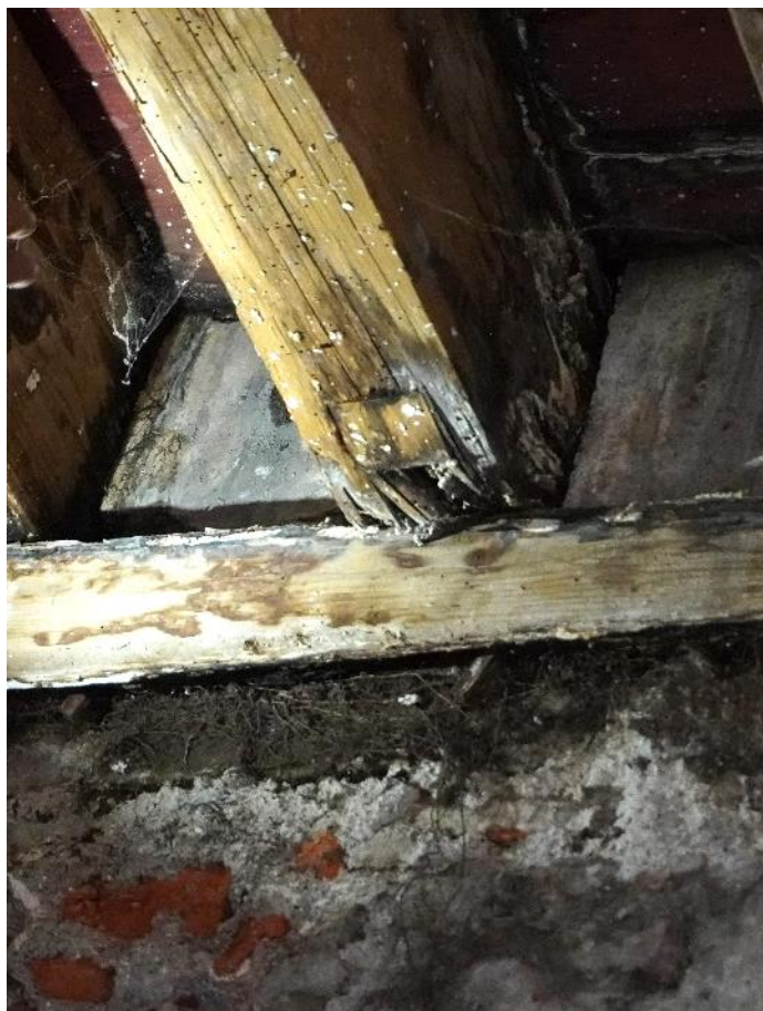
Figura 113. Estado del intradós de bóvedas en sacristía
