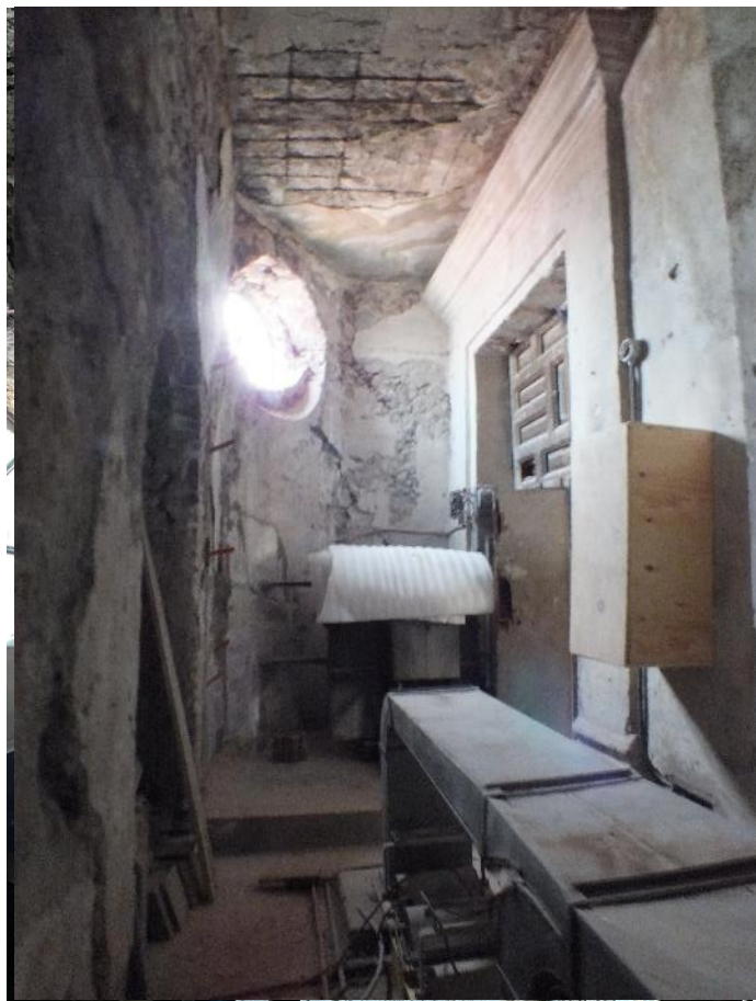
Figura 167. Cuarto anexo con retiro de aplanados
