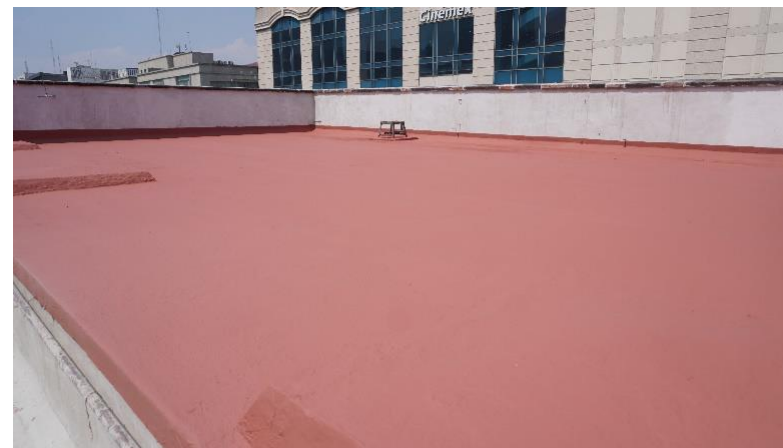
Figura 20. Estado final de cubiertas.
