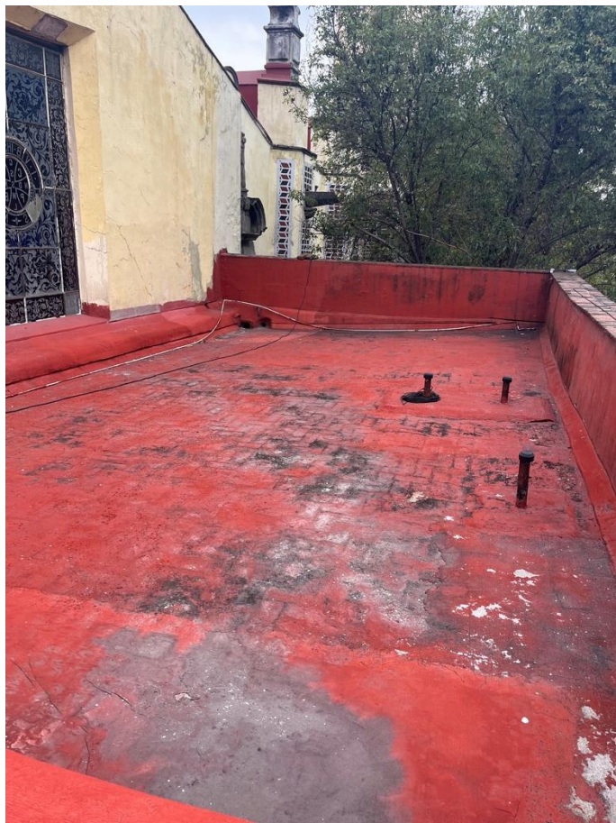
Figura 148. Estado de cubiertas previo a intervención
