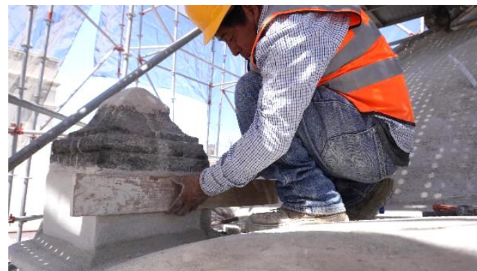
Figura 53. Reintegración de aplanados.
