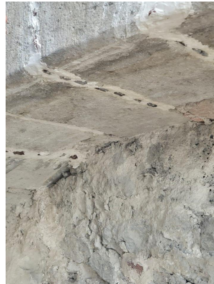
Figura 197. Rejunteo de cantera terminado
