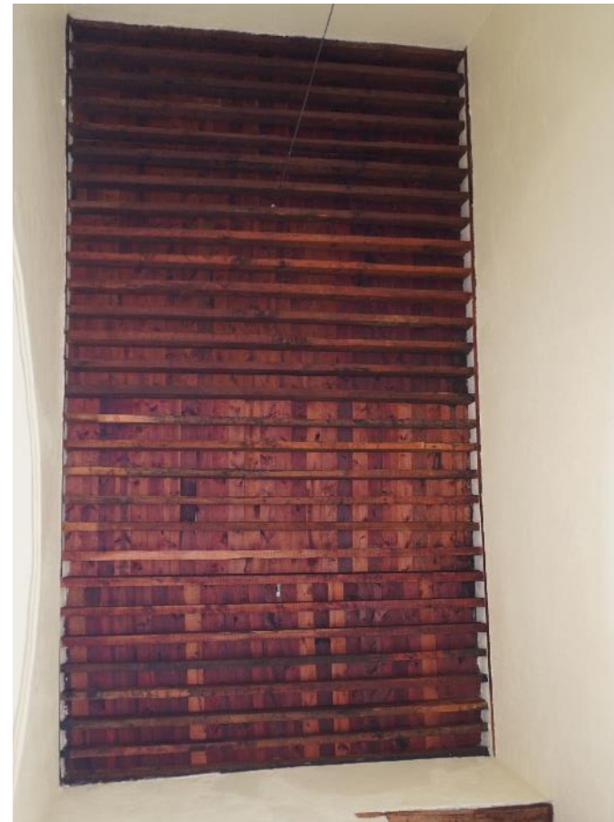
Figura 115. Acabado final en intradós de bóvedas en sacristía
