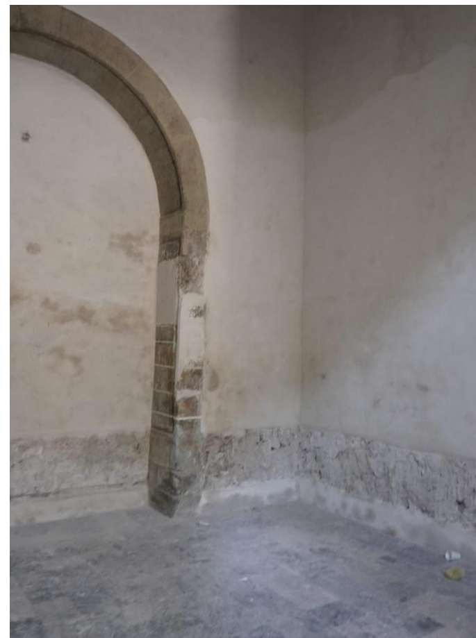
Figura 7. Acabado final en capilla
