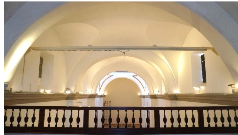
Figura 32. Estado final de intradós de bóvedas.
