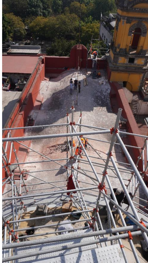
Figura 3. Liberación de enladrillado en trayectoria de grietas.
