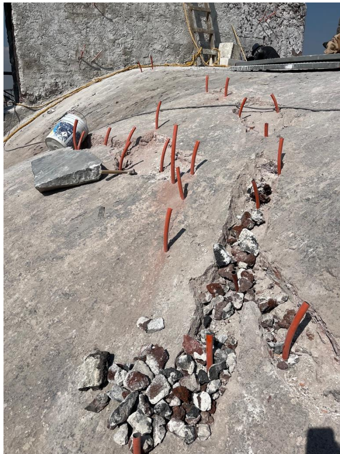
Figura 16. Proceso de consolidación en extradós de bóveda de coro
