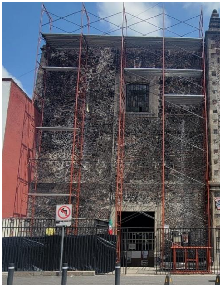
Figura 178. Montaje de andamios en fachada sur
