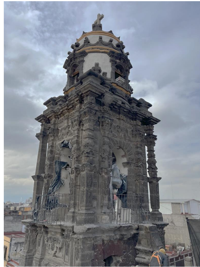
Figura 33. Torre tras intervención
