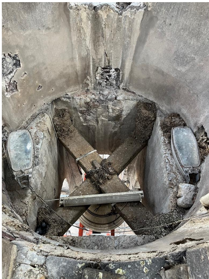
Figura 22. Estado del interior del cupulín en torre campanario
