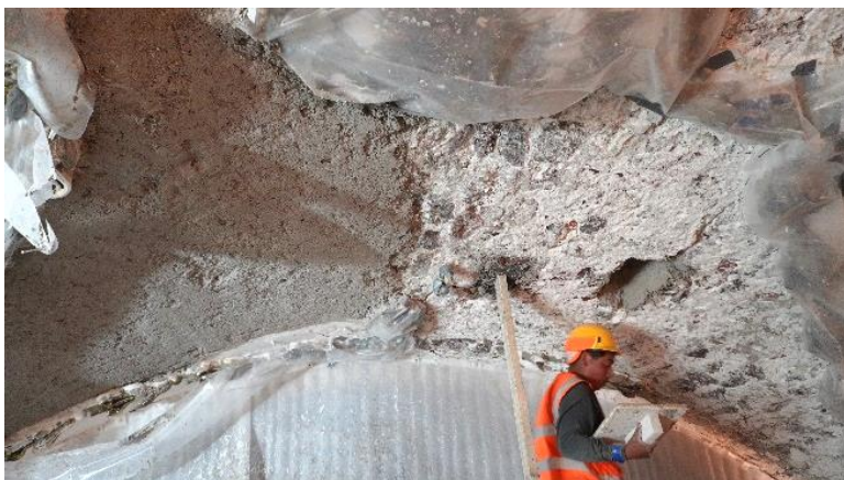
Figura 76. Colocación de grapas y aplanados en grietas
