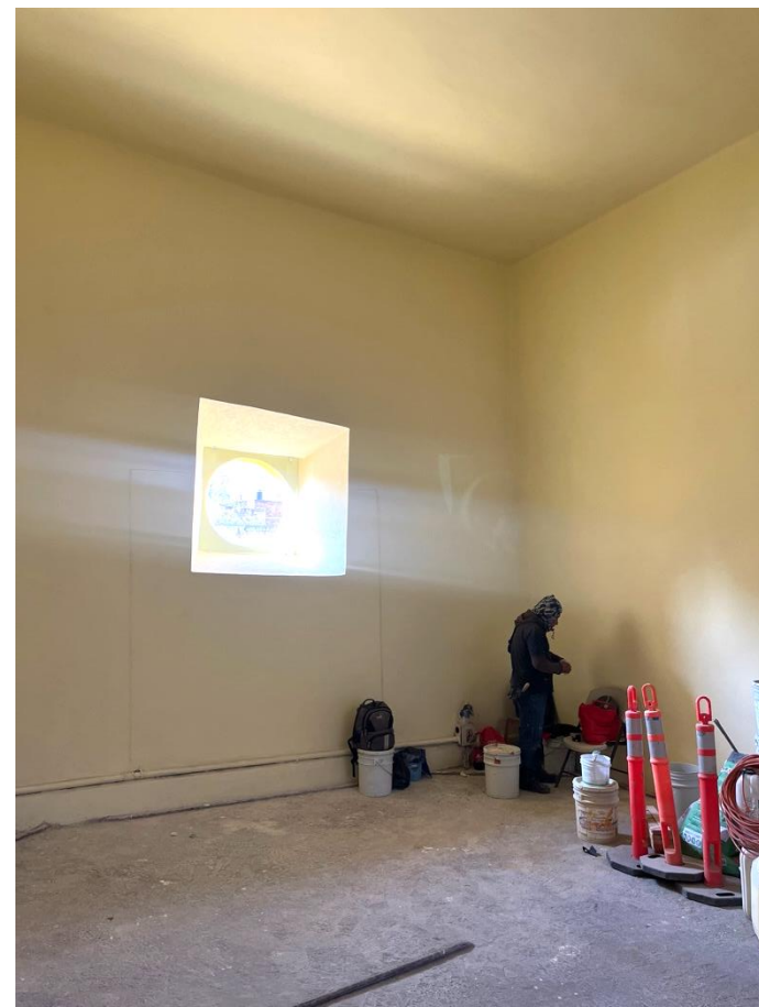
Figura 106. Acabado final en zona de coro
