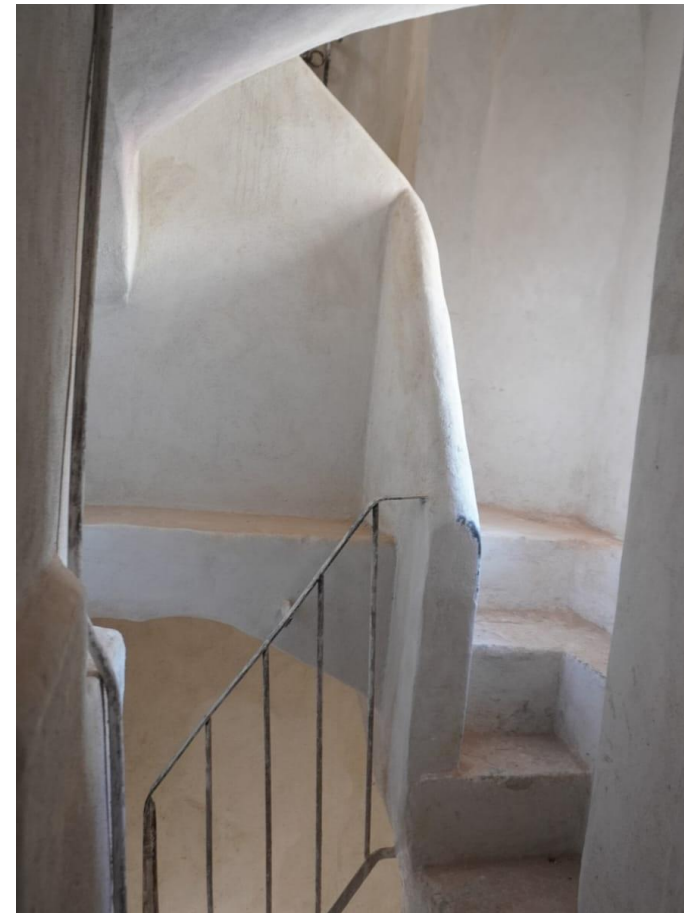
Figura 27. Acabado final en interior de la torre
