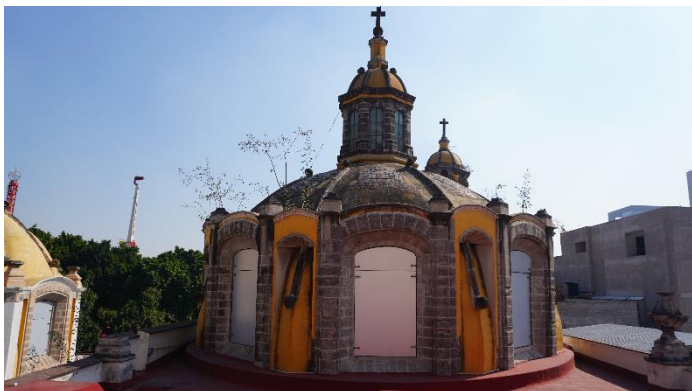
Figura 44. Estado inicial de extradós de Cúpula principal.
