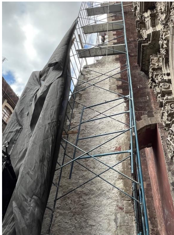
Figura 53. Proceso de intervención en contrafuertes de fachada sur
