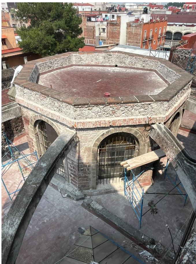
Figura 118. Proceso de intervención en tambor
