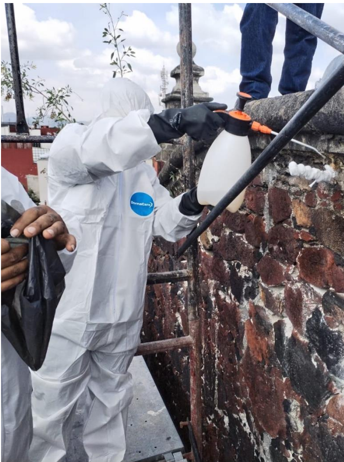
Figura 202. Proceso de erradicación de flora parásita
