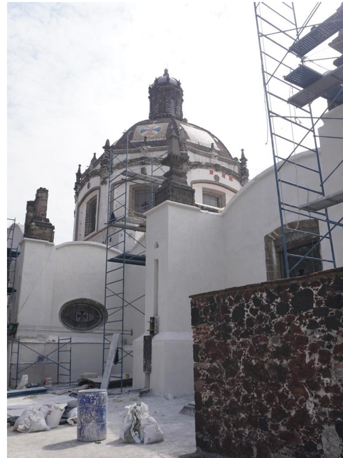
Figura 51. Acabado final en fachada norte
