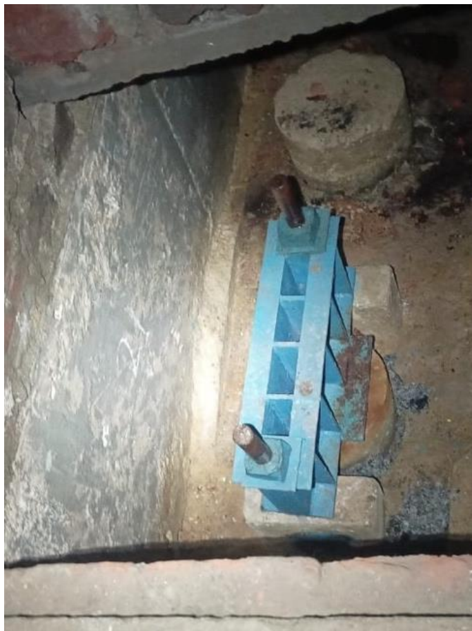
Figura 160. Estado de pilotes previo a intervención
