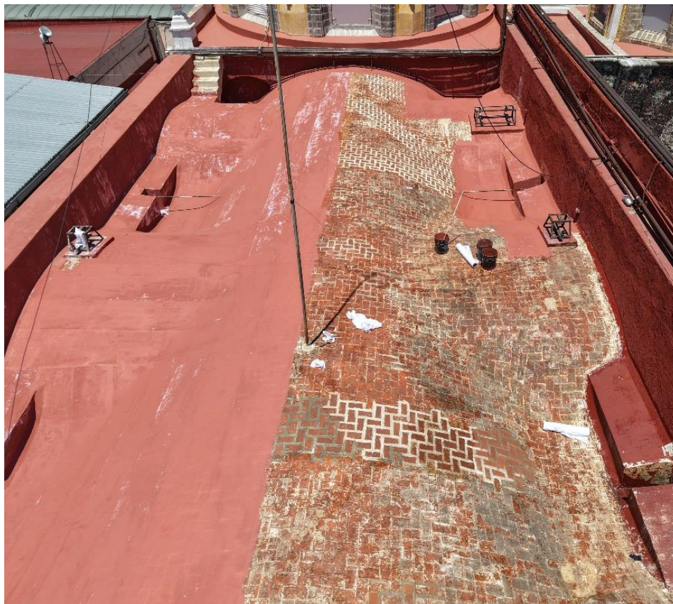
Figura 11. Aplicación de Impermeabilización..
