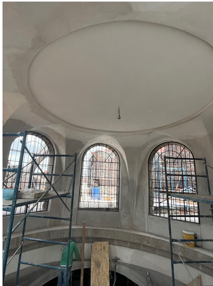
Figura 111. Proceso de intervención en interior de tambor
