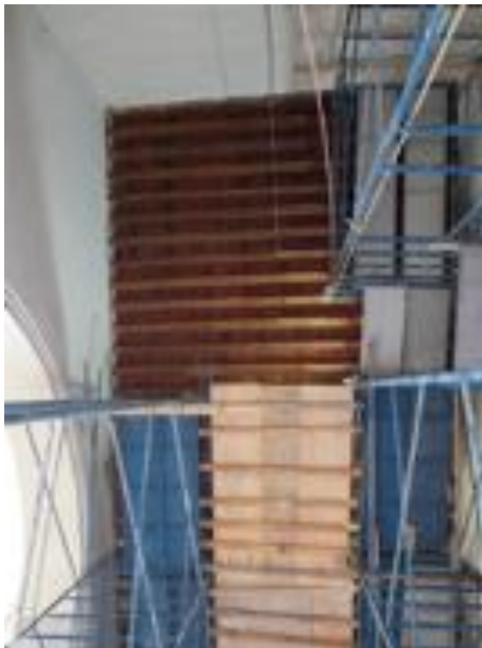
Figura 114. Proceso de intervención en intradós de bóvedas en sacristía
