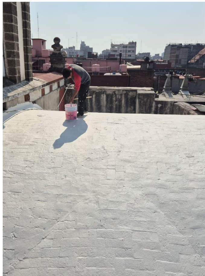
Figura 206. Proceso de Integración de impermeabilizante en cubiertas
