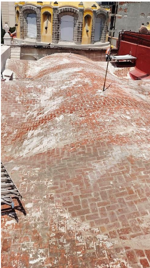
Figura 10. Reintegración de enladrillado.
