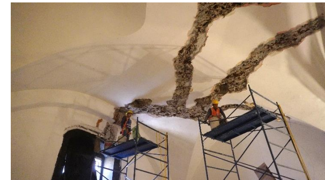
Figura 37. Liberación de aplanado en trayectoria de grietas.
