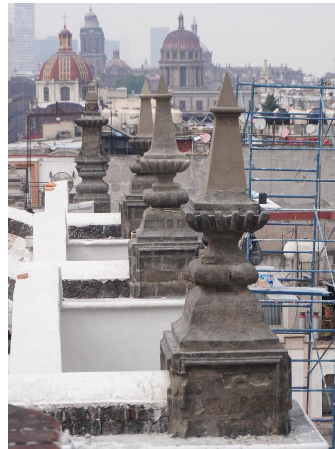
Figura 57. Acabado final en pináculos
