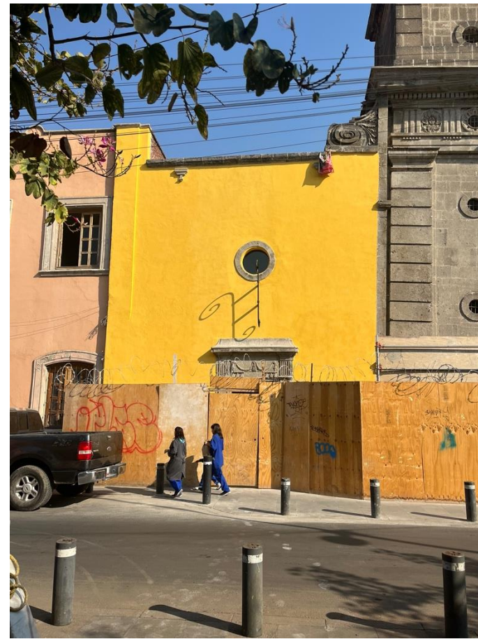
Figura 77. Acabado final en fachada de capilla
