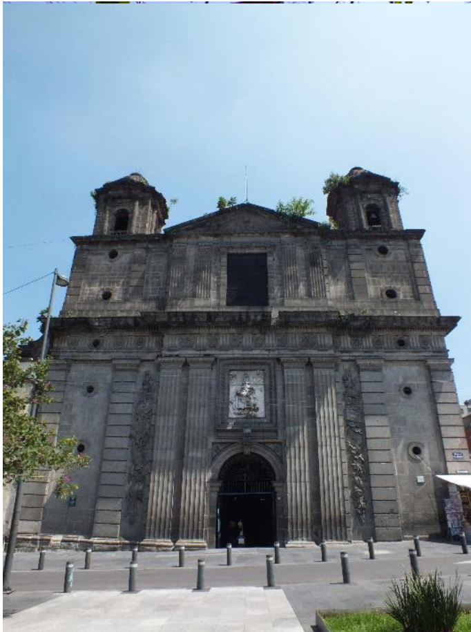
Figura 72. Estado de la fachada sur
