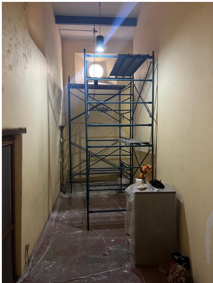
Figura 155. Estado de sacristía
