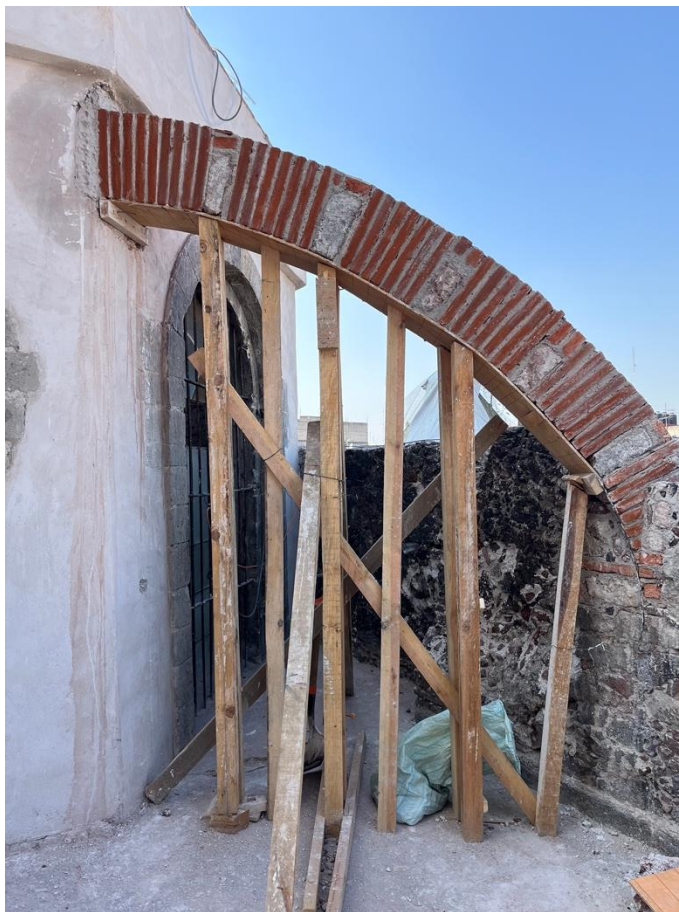
Figura 124. Proceso de reconstrucción del arco botarel
