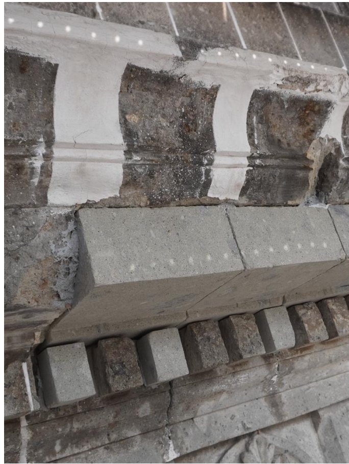
Figura 82. Proceso de intervención en elementos de cantera en fachada principal
