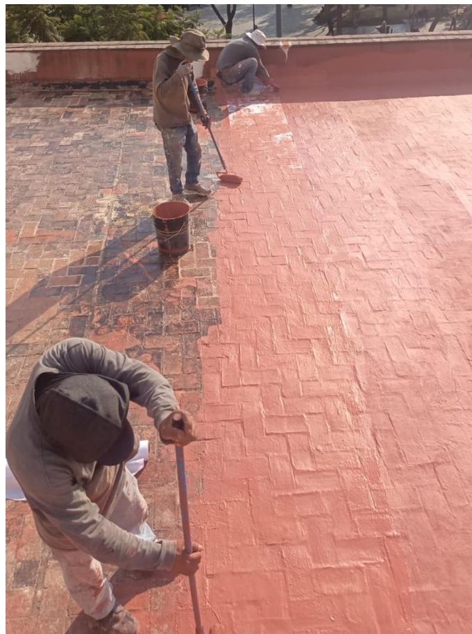
Figura 149. Proceso de aplicación de nuevo impermeabilizante
