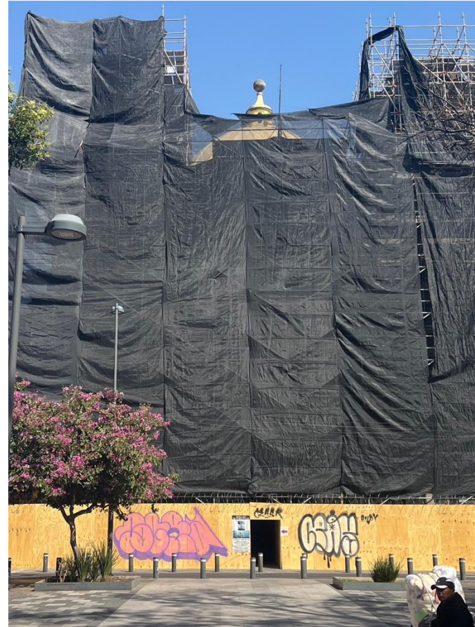
Figura 73. Proceso de intervención en fachada sur
