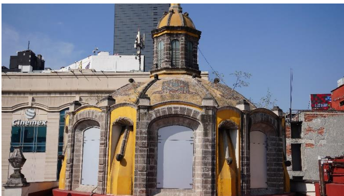
Figura 48. Estado Inicial de extradós de Cúpula Principal.
