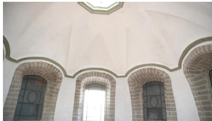
Figura 67. Estado final de intradós de Cúpula Principal.
