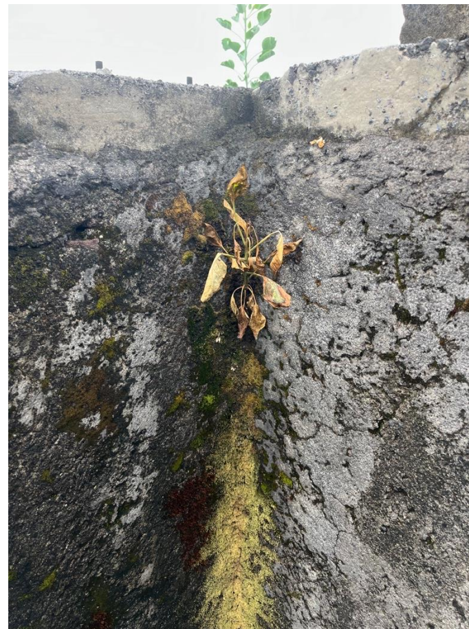
Figura 204. Flora parásita tras la aplicación del herbicida
