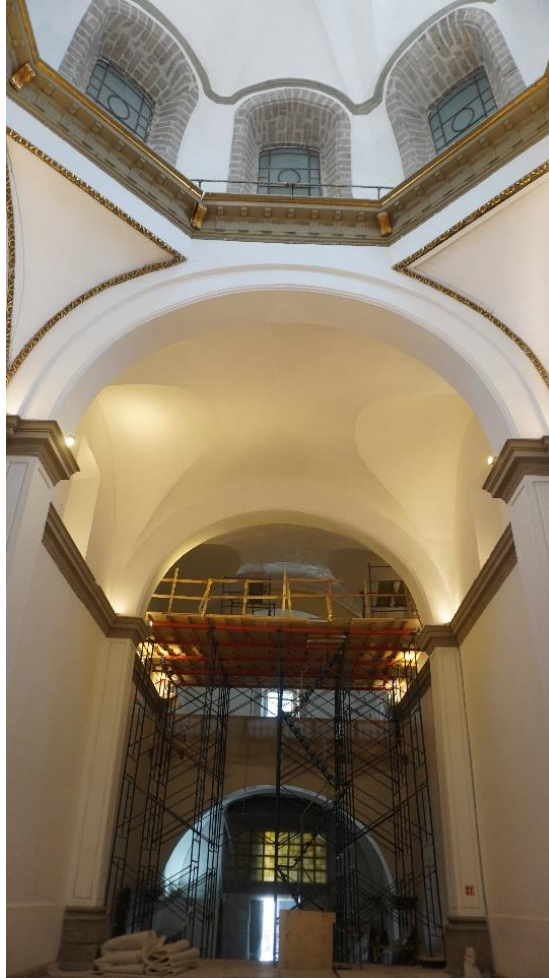
Figura 30. Estado final de intradós de bóvedas.
