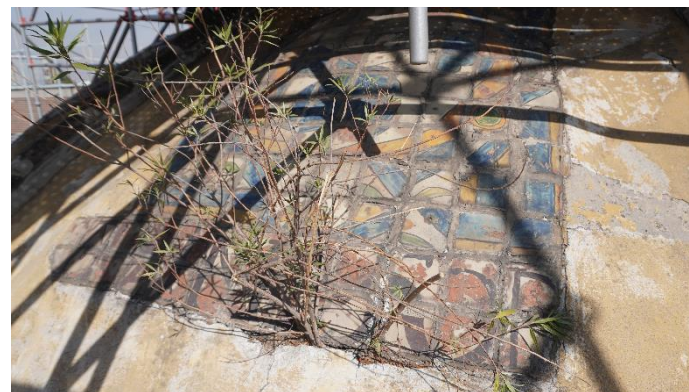
Figura 47. Estado inicial de extradós de Cúpula Principal.
