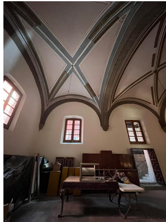
Figura 67. Acabado final en paramentos de sacristía
