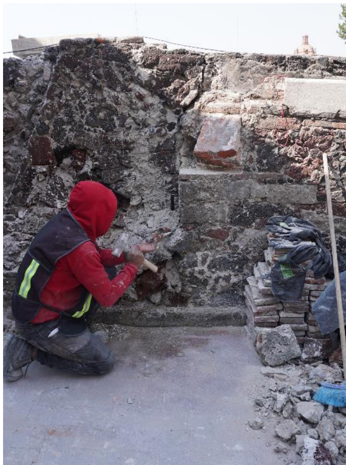
Figura 127. Proceso de intervención en paramentos de azotea
