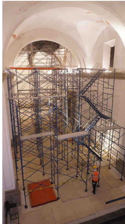
Figura 23. Armado de andamiaje en Nave Principal.
