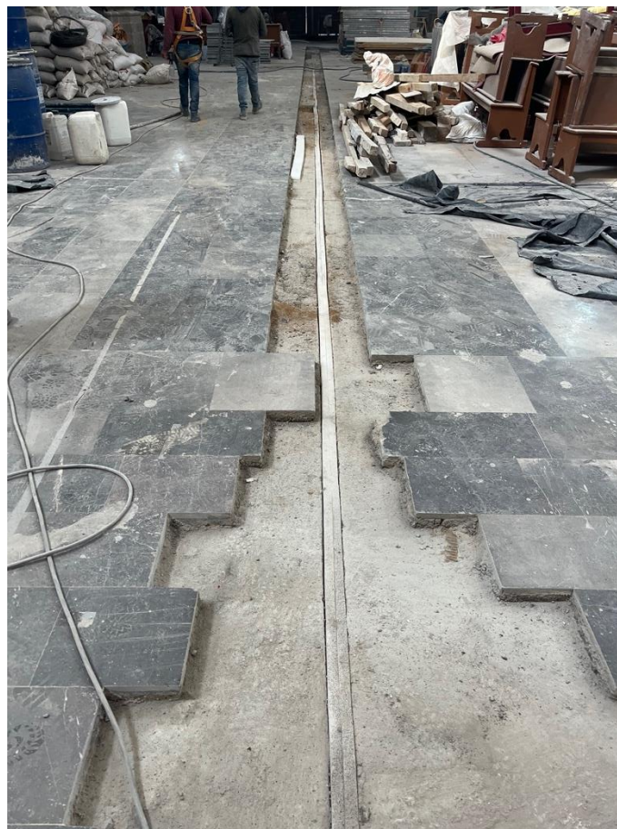
Figura 9. Proceso de intervención en juntas y piso de la nave principal
