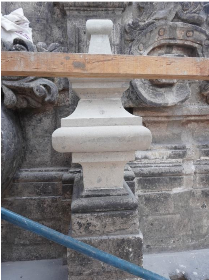
Figura 43. Integración de pináculo en fachada principal
