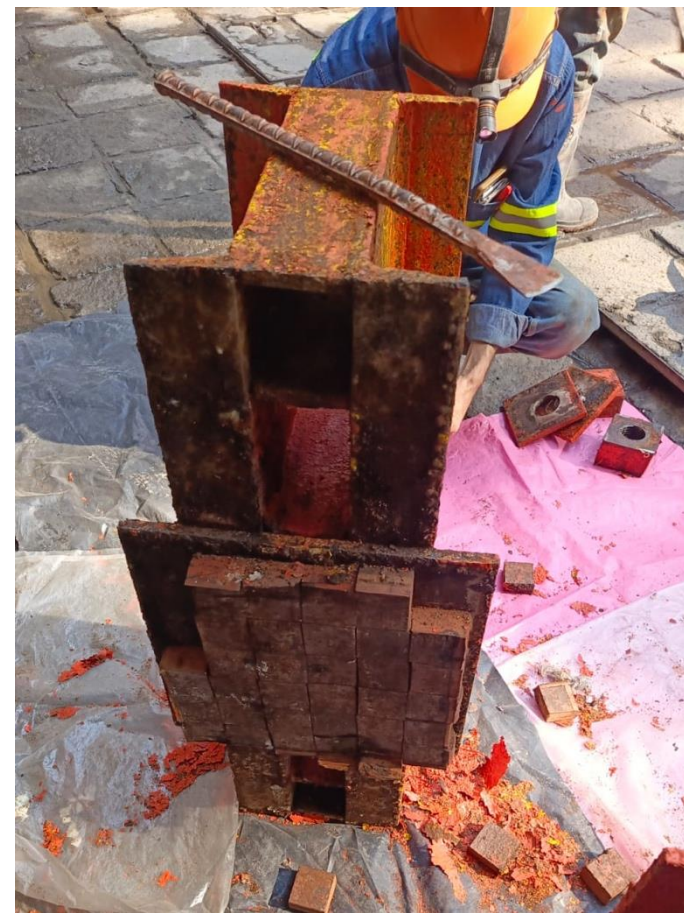
Figura 162. Limpieza de cabezal y sustitución de celda de deformación
