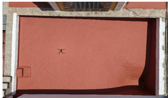
Figura 90. Estado final de Bóvedas de Capilla de Dolores.
