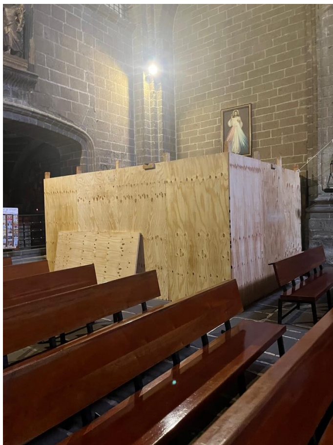
Figura 175. Bodega y oficina provisional
