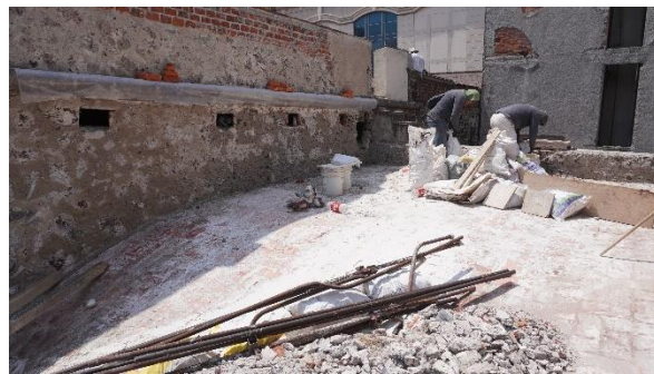
Figura 89. Liberación de impermeabilizante existente.
