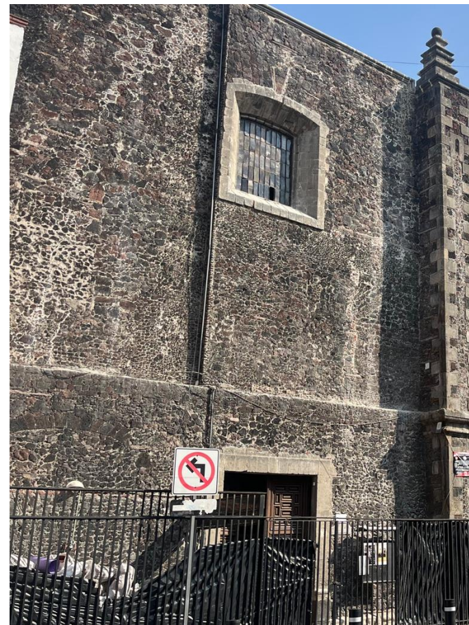
Figura 180. Fachada sur tras intervención
