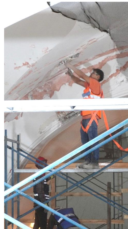
Figura 25. Liberación de aplanado en trayectoria de grietas..
