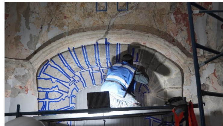
Figura 6. Consolidación de cantera.
