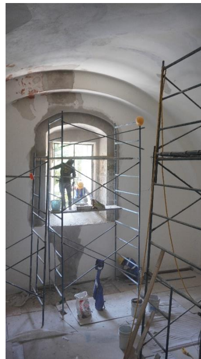
Figura 41. Integración de aplanados en intradós de bóveda del Coro.
