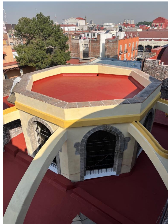
Figura 119. Acabado final en tambor
