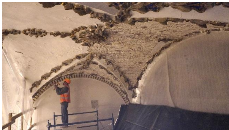
Figura 75. Retiro de aplanados en bóveda.
