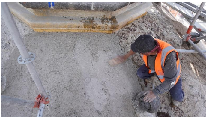
Figura 54. Reintegración de aplanados.
