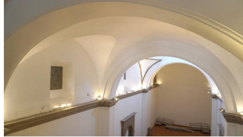
Figura 31. Estado final de intradós de bóvedas.
