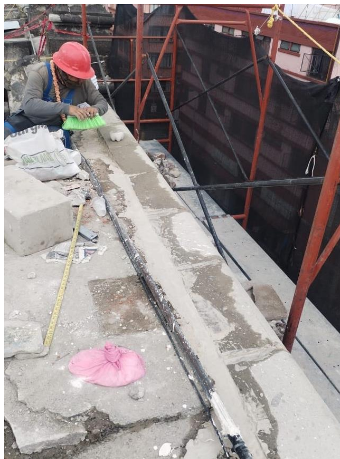
Figura 182. Proceso de integración de cornisa
