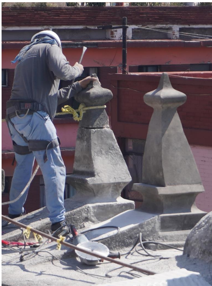
Figura 189. Proceso de labrado de pináculos nuevos
