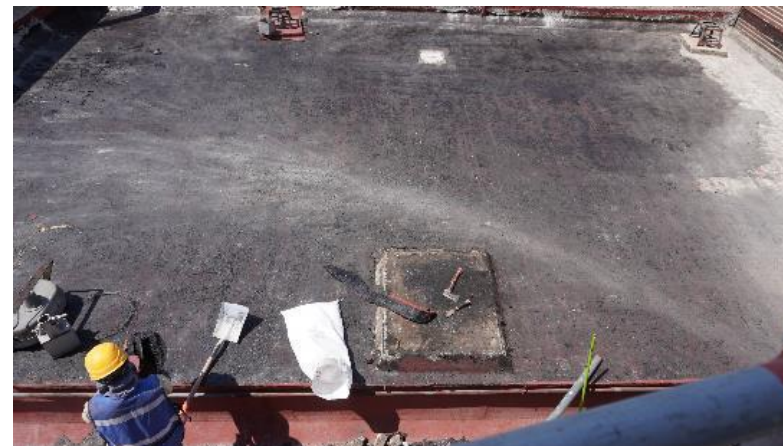
Figura 18. Liberación de impermeabilizante existente..
