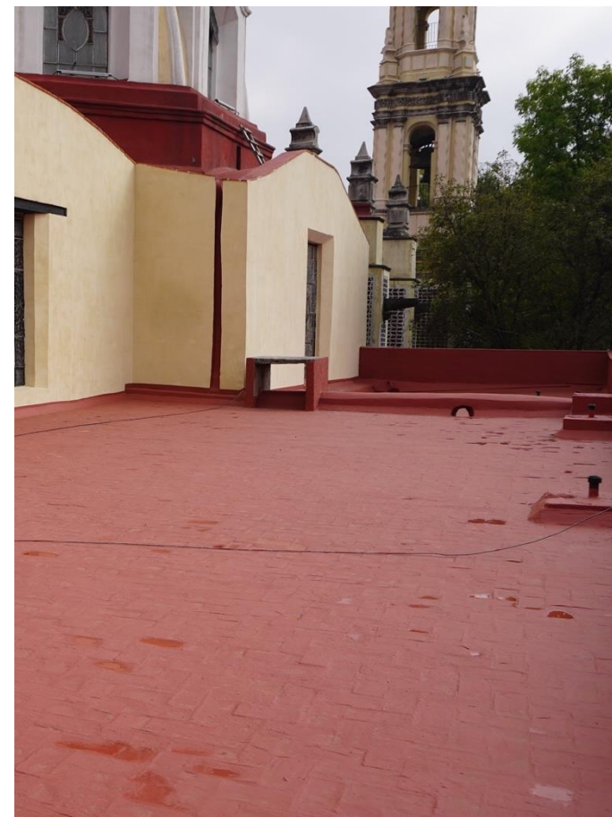
Figura 150. Aplicación de impermeabilizante completa
