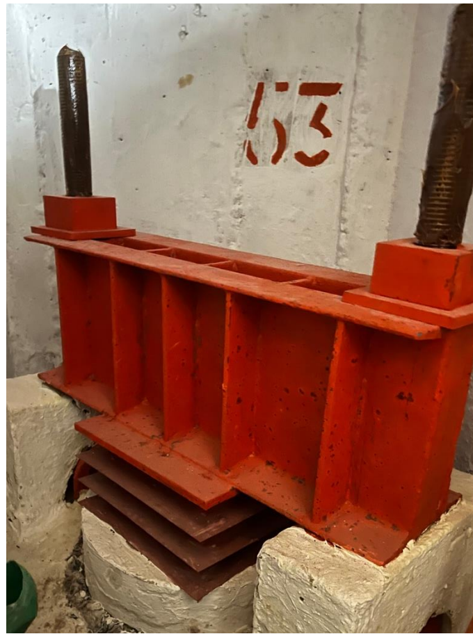
Figura 164. Pilote 53 tras intervención
