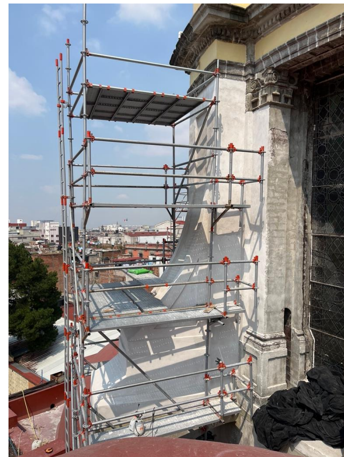
Figura 132. Proceso de restauración de contrafuertes
