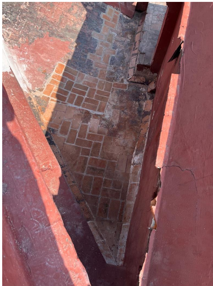
Figura 152. Proceso de reintegración de enladrillado
