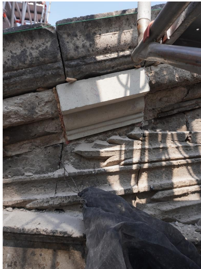
Figura 79. Proceso de intervención en frontón
