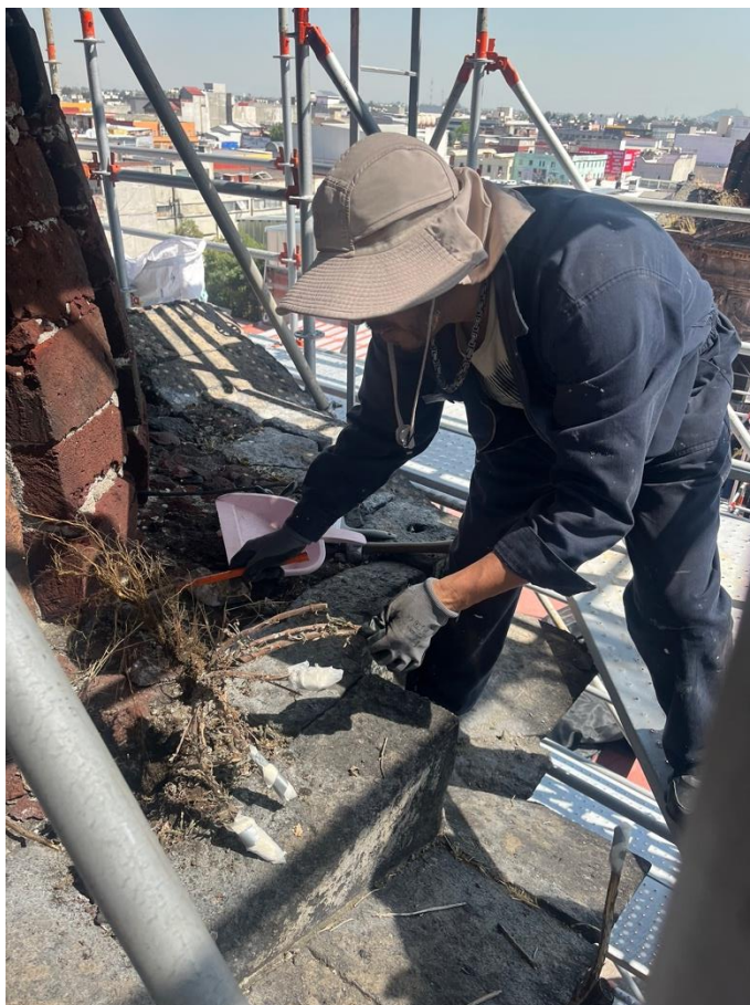
Figura 89. Proceso de erradicación de flora parásita en torres campanario
