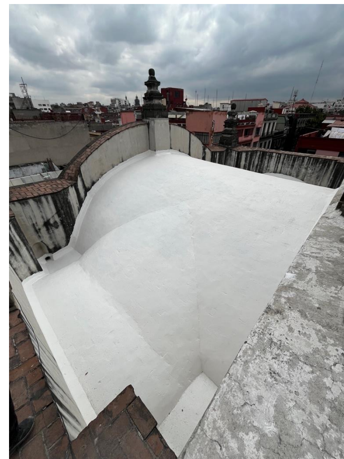
Figura 207. Integración de impermeabilizante completa en cubiertas
