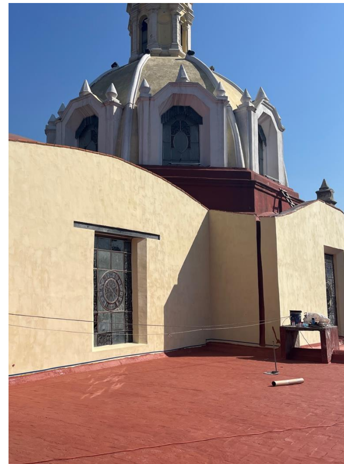
Figura 139. Acabado final en fachada sur
