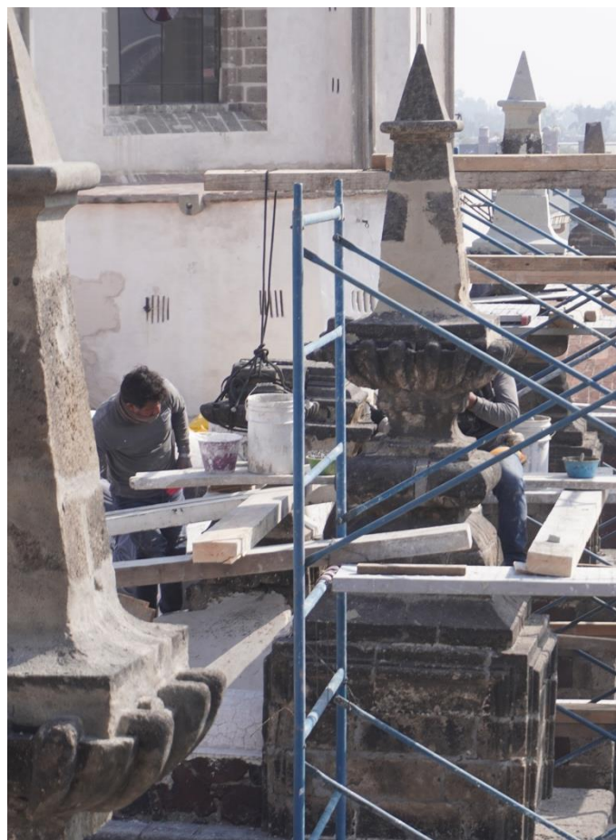
Figura 56. Proceso de intervención en pináculos
