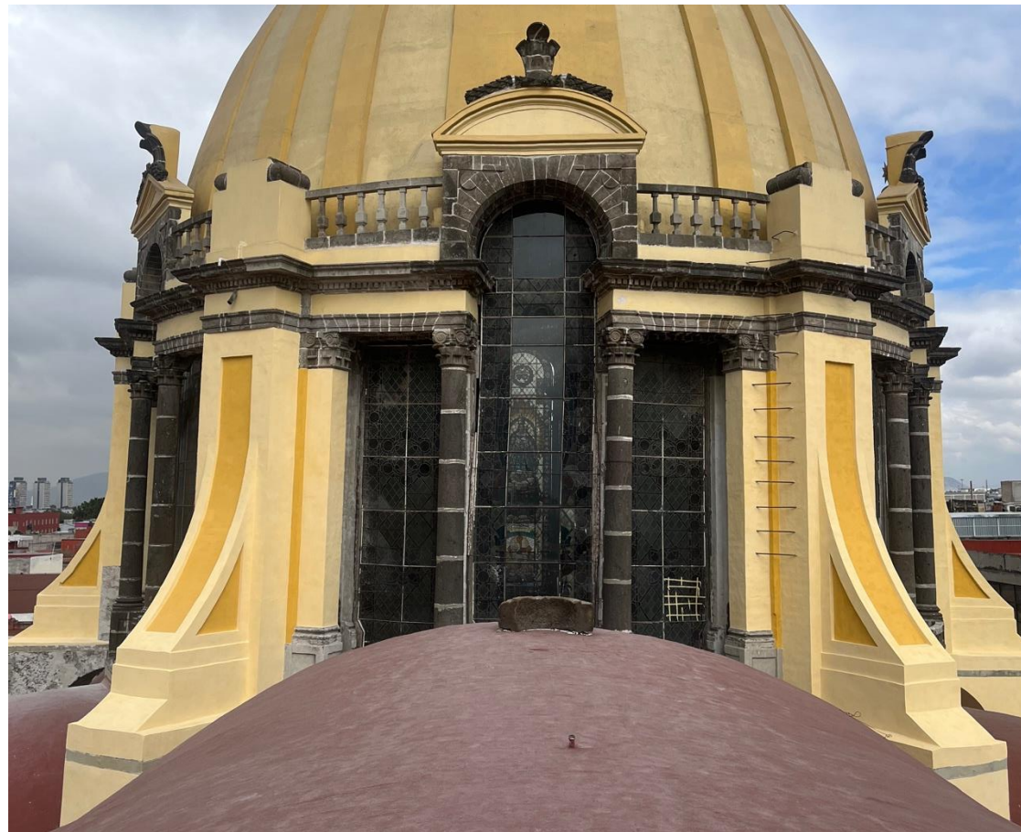
Figura 135. Acabado final en contrafuertes
