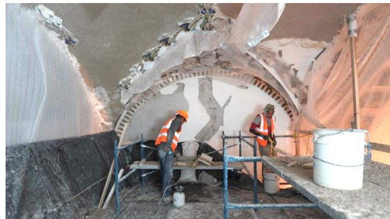
Figura 78. Reintegración de aplanados .
