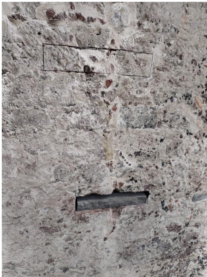
Figura 193. Proceso de consolidación en fachada poniente
