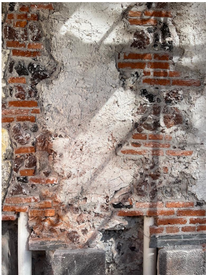
Figura 76. Proceso de intervención en fachada de capilla
