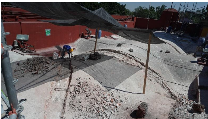
Figura 6. Liberación de enladrillado en Nave Principal.
