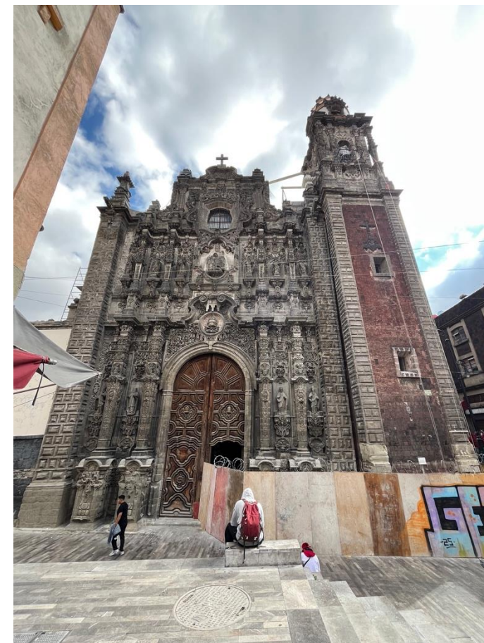
Figura 39. Fachada principal tras intervención
