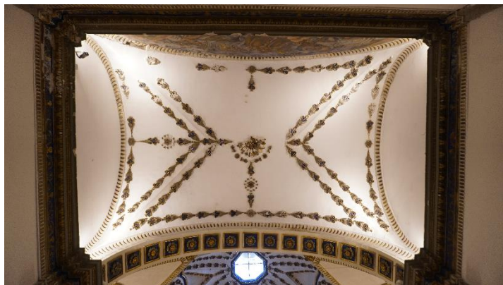
Figura 81 .Estado final de intradós de bóveda de Capilla de Dolores.
