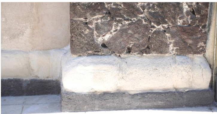
Figura 97. Aplanado en muro Norte.
