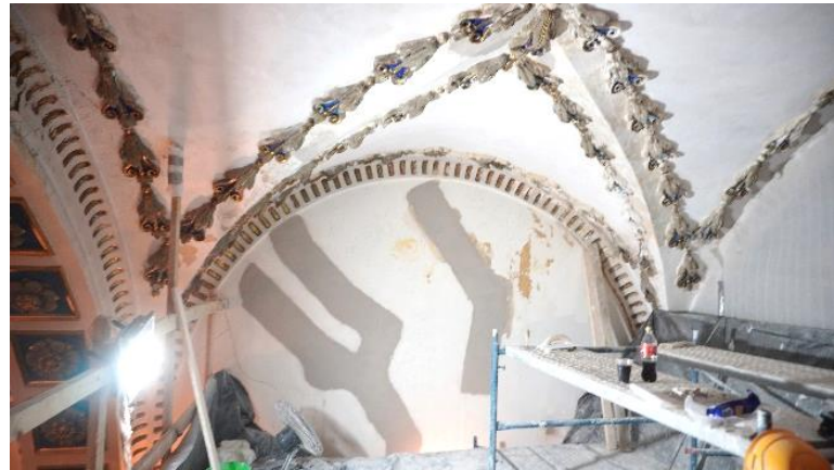
Figura 80. Reintegración de aplanados y pintura a la cal en bóveda.
