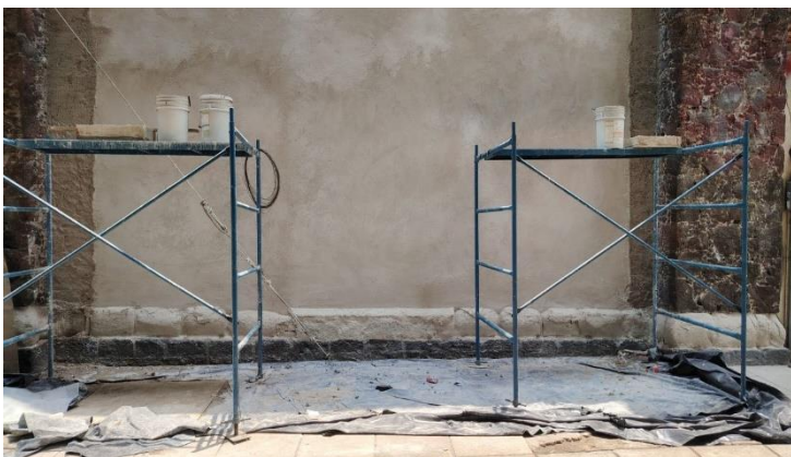
Figura 97. Aplanado en muro Norte.
