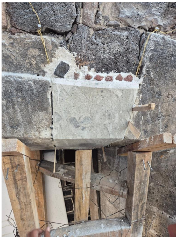
Figura 199. Proceso de sustitución de dovela en fachada poniente
