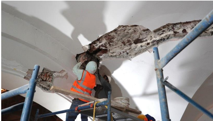
Figura 26. Consolidación con grapas en trayectoria de grietas..
