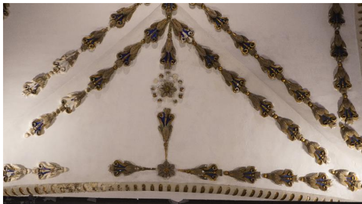
Figura 83 .Estado final de intradós de bóveda de Capilla de Dolores.
