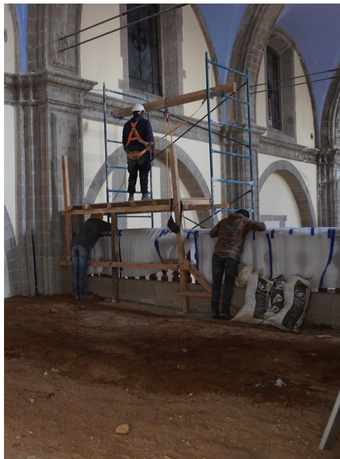
Figura 3. Proceso de nivelación en coro
