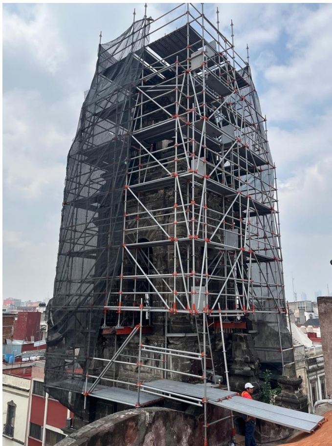
Figura 32. Proceso de intervención la torre
