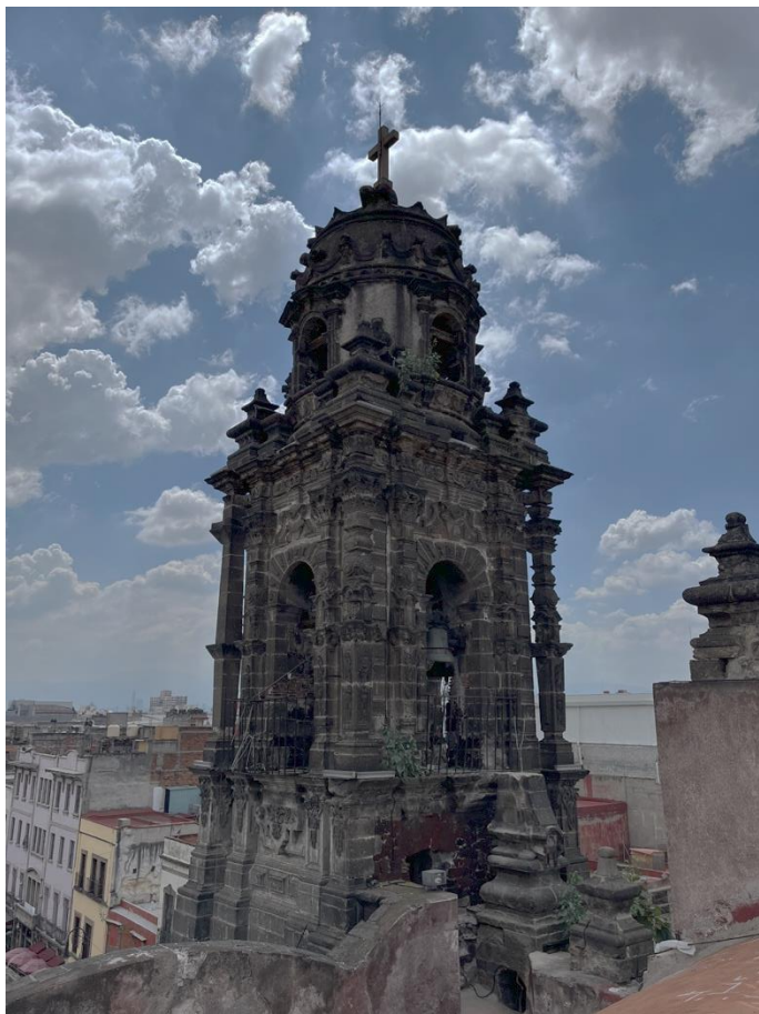
Figura 31. Estado de la torre campanario previo a intervención
