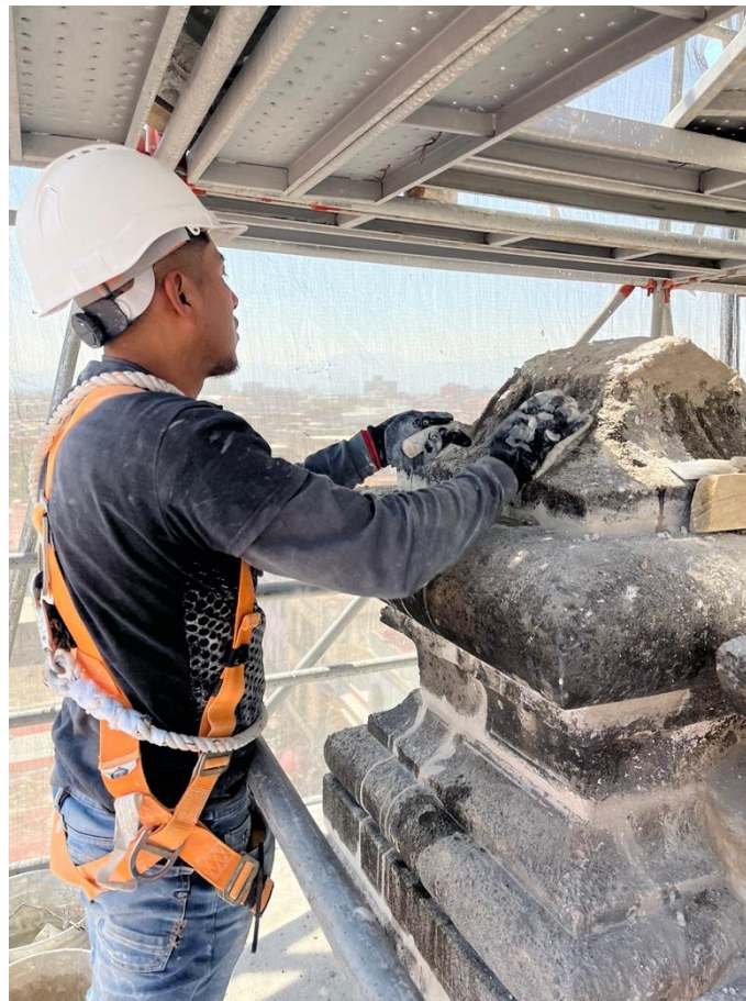
Figura 29. Proceso de intervención en pináculos de torre campanario
