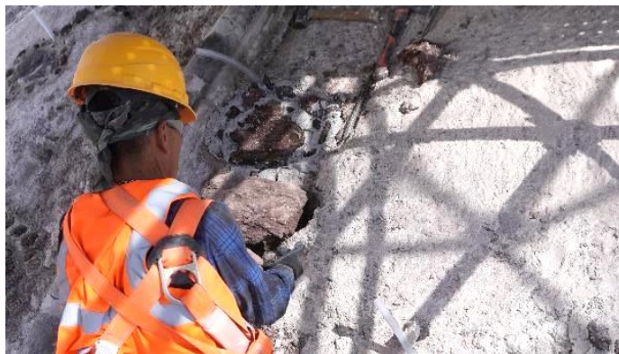
Figura 52. Consolidación por medio de grapas.
