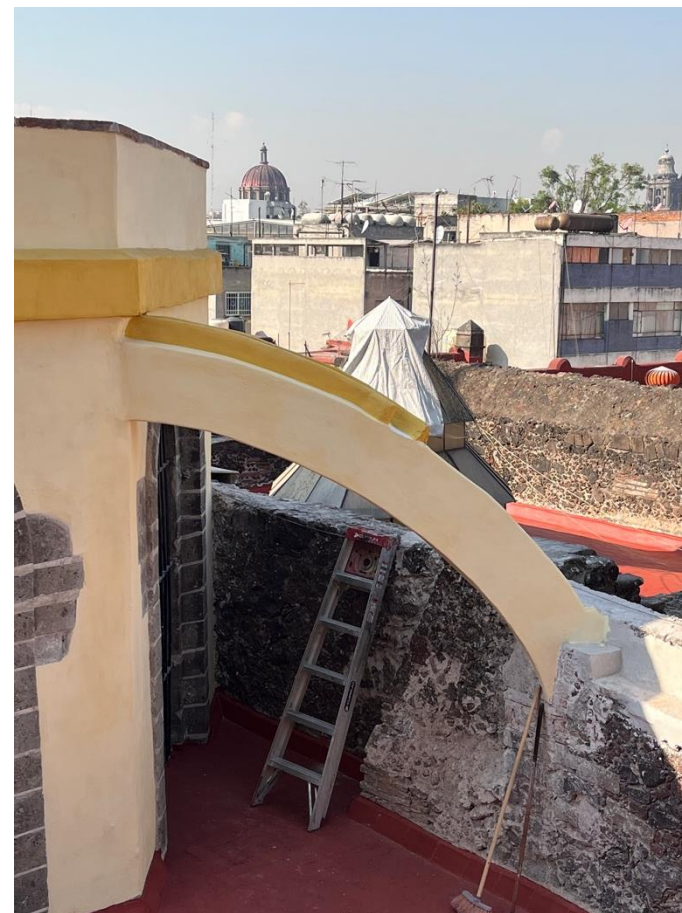
Figura 125. Acabado final en arco botarel
