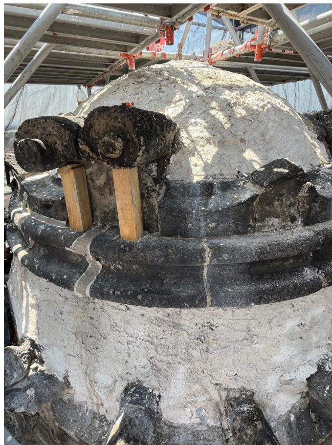
Figura 20. Proceso de intervención en torre campanario
