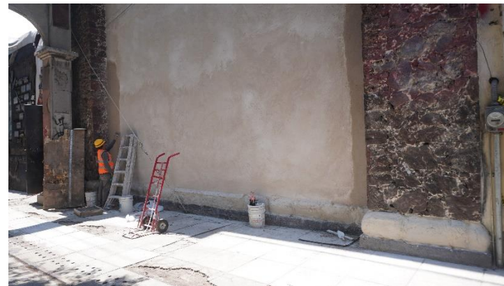
Figura 98. Aplanado en Muro Norte
