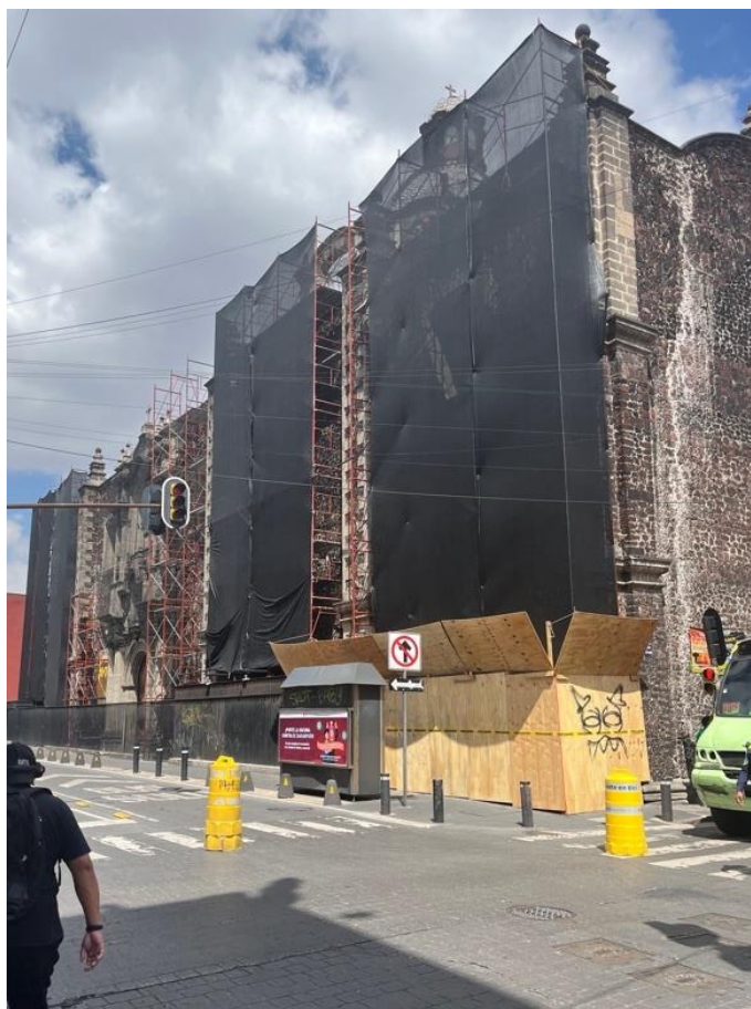
Figura 179. Fachada sur durante su intervención
