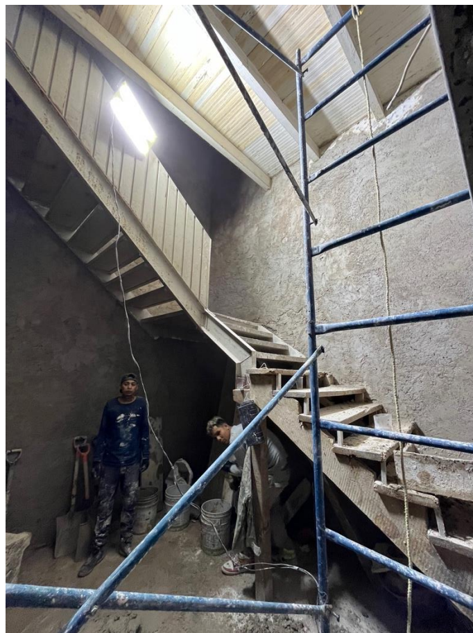
Figura 63. Proceso de intervención en cubo de escaleras
