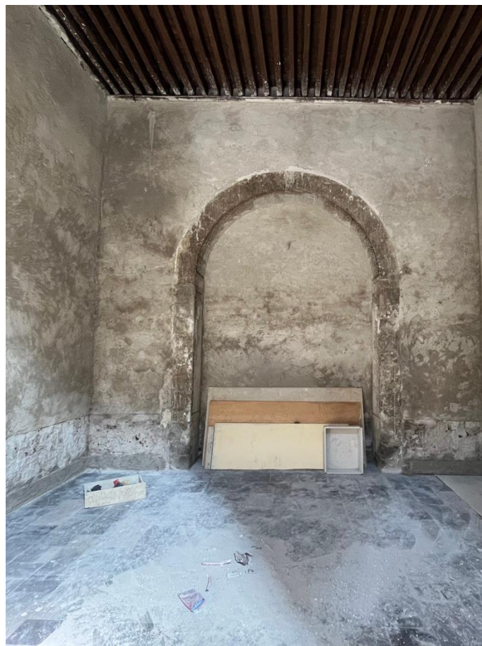
Figura 6. Proceso de intervención en capilla
