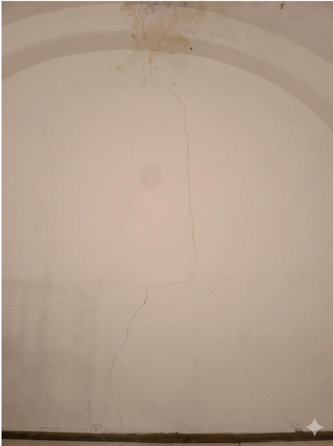
Figura 34. Estado inicial en muro de Fachada.
