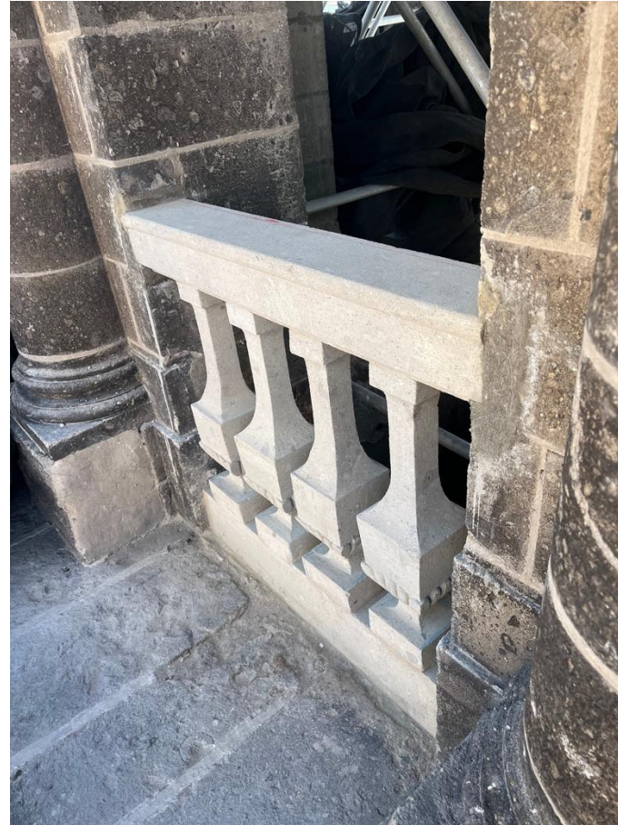
Figura 98. Proceso de intervención de las balaustradas
