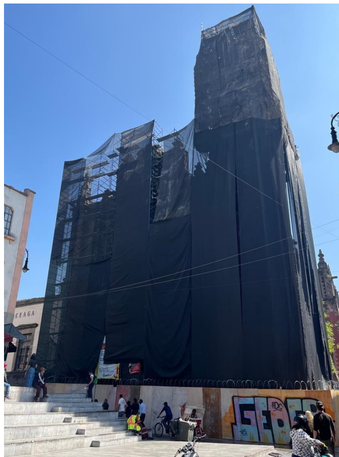
Figura 38. Proceso de intervención en fachada principal
