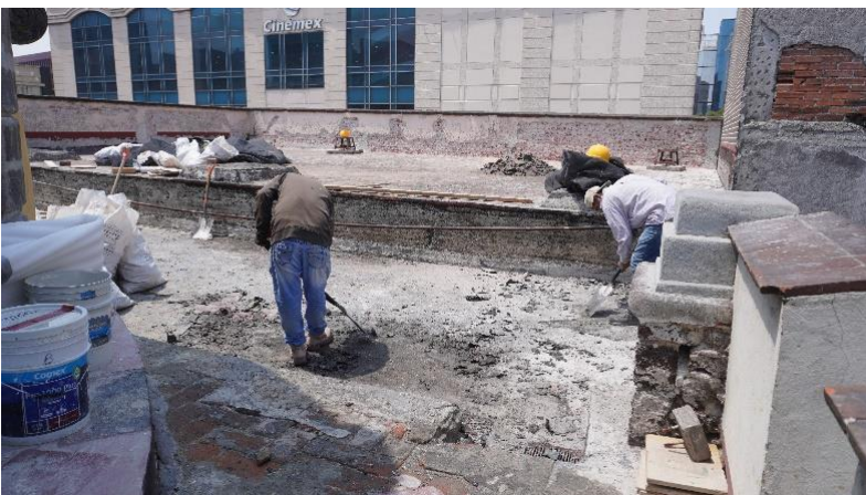
Figura 19. Liberación de impermeabilizante en cubiertas.
