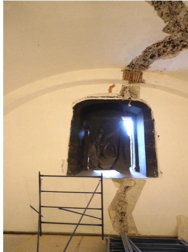
Figura 35. Liberación de aplanados en trayectoria de grietas.
