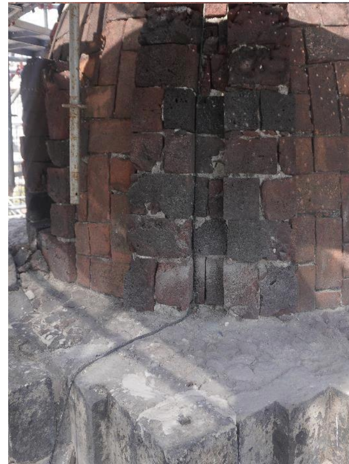
Figura 90. Terminación de erradicación de flora parásita en torres campanario
