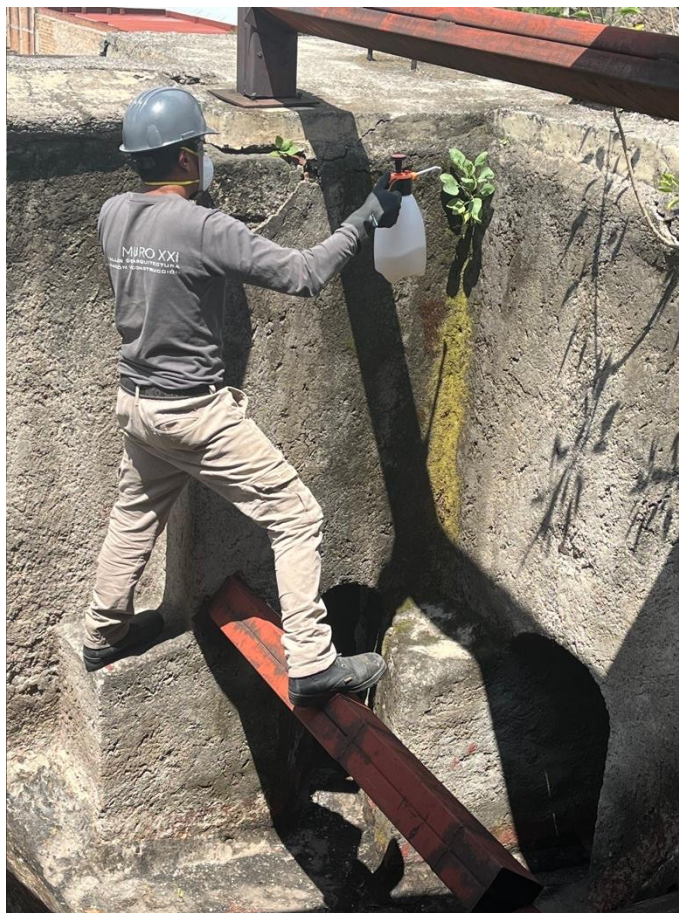
Figura 203. Proceso de erradicación de flora parásita
