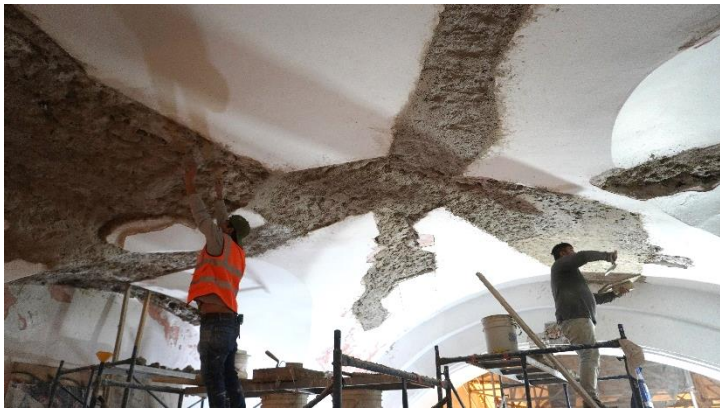
Figura 28. Reintegración de aplanados en trayectoria de grietas..
