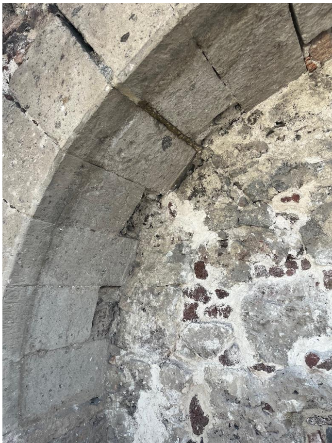
Figura 195. Juntas de cantera limpias
