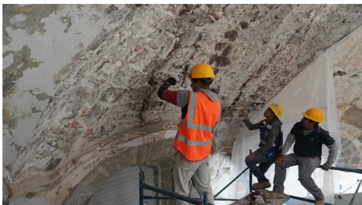
Figura 7. Liberación de aplanados en trayectoria de grutas.
