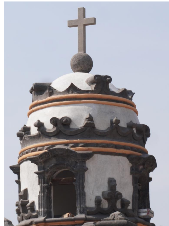
Figura 21. Acabado final en corona de torre campanario
