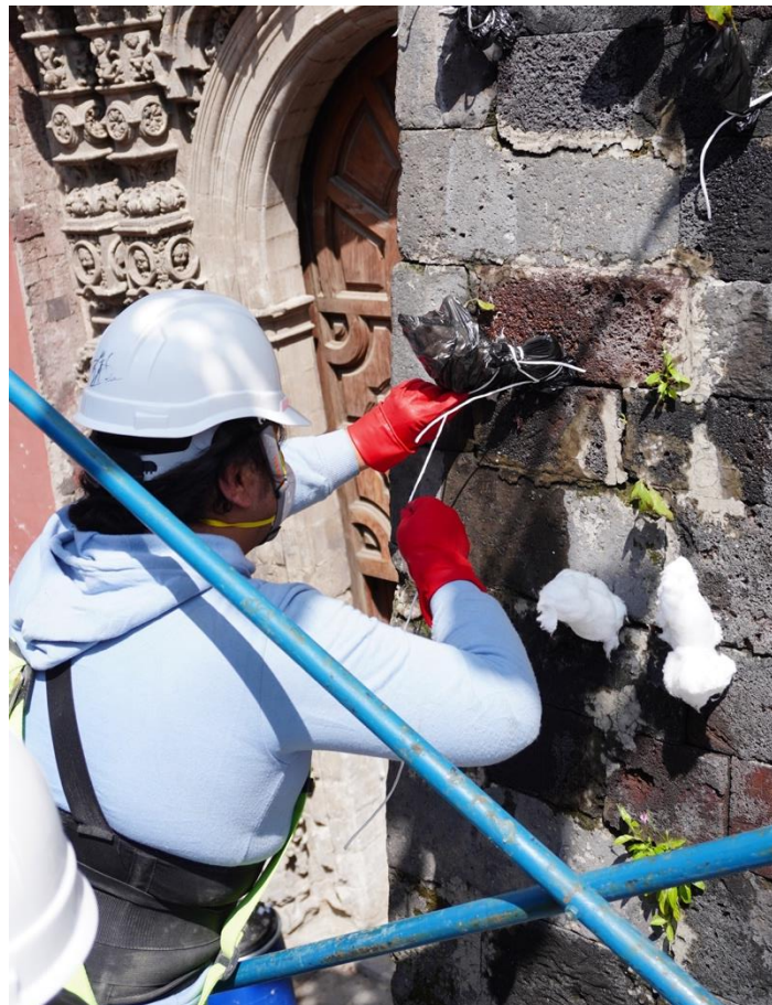
Figura 47. Proceso de erradicación de flora parásita en fachada sur
