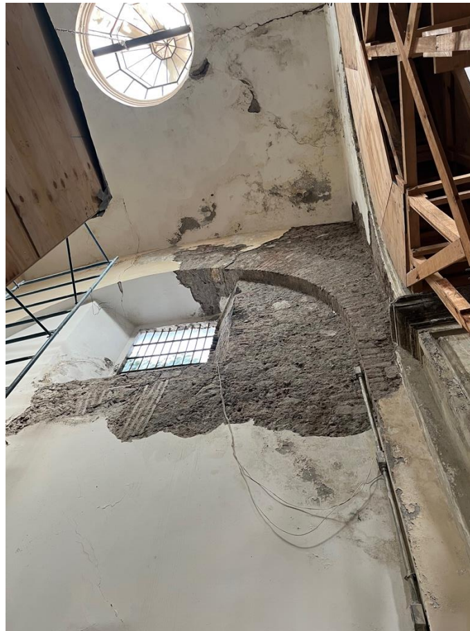
Figura 102. Proceso de intervención en zona de nichos
