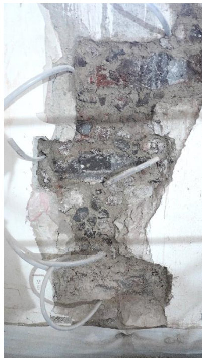
Figura 40. Colocación de grapas de tezontle y puertos de inyección.
