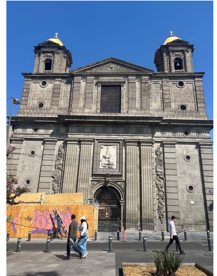
Figura 74. Fachada sur tras intervención
