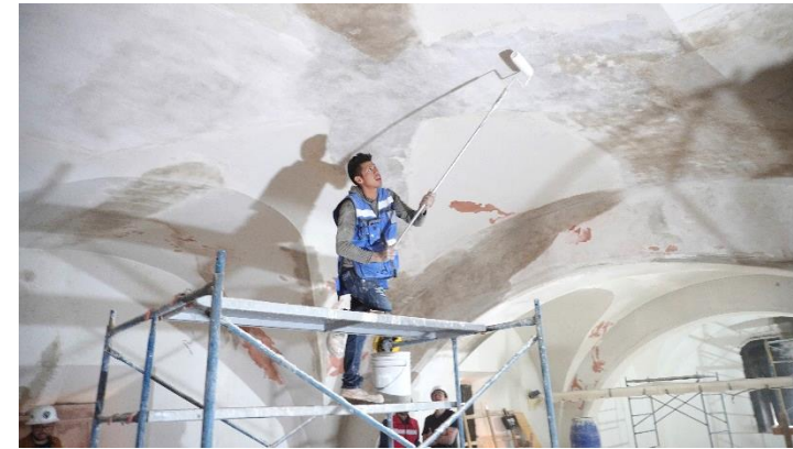
Figura 29. Reintegración de pintura a la cal en intradós de bóvedas.
