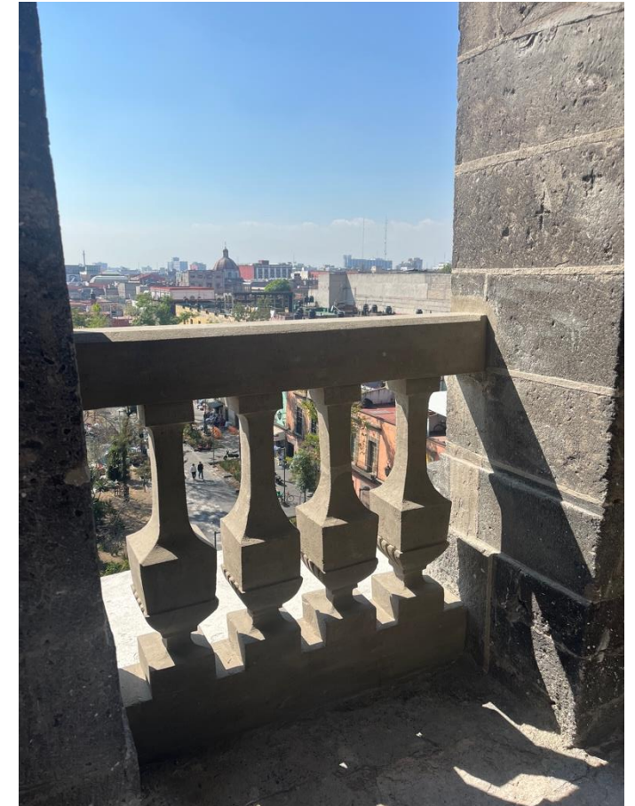
Figura 99. Acabado final de las balaustradas
