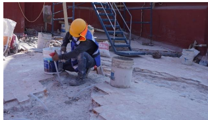
Figura 7 Inyección de grietas.
