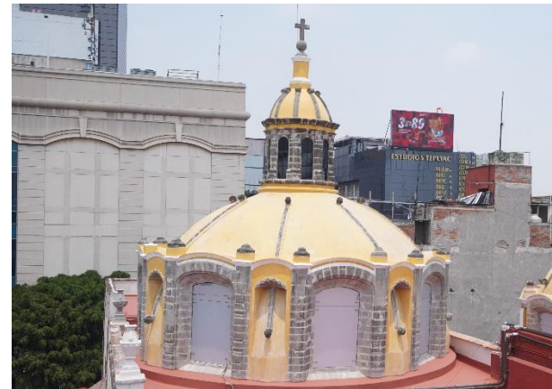
Figura 60. Estado final de extradós de Cúpula Principal.
