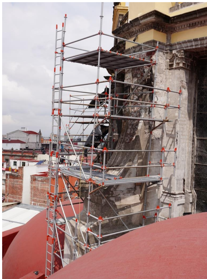
Figura 131. Proceso de restauración de contrafuertes
