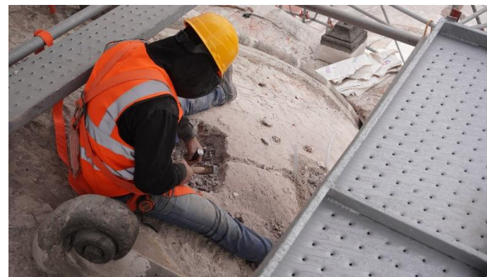
Figura 51. Apertura de cajas para grapas.
