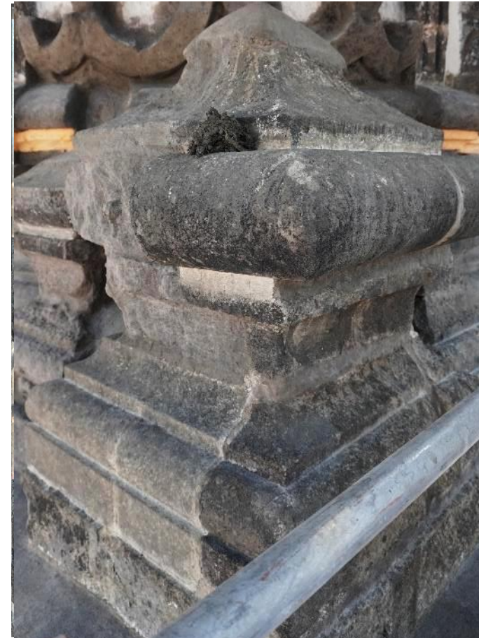
Figura 30. Acabado final en pináculos de torre campanario
