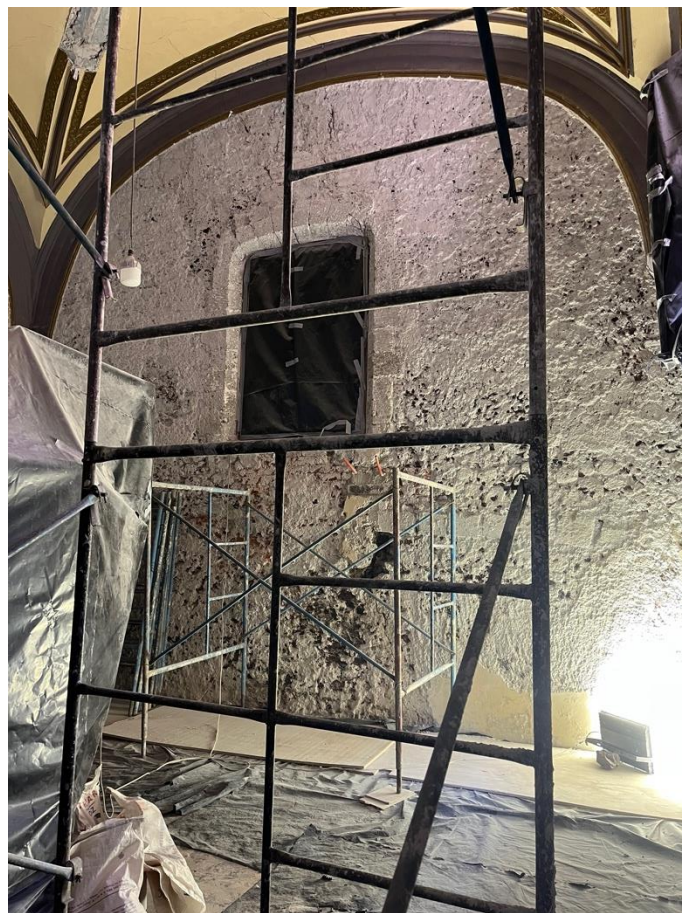
Figura 66. Proceso de intervención en paramentos de sacristía
