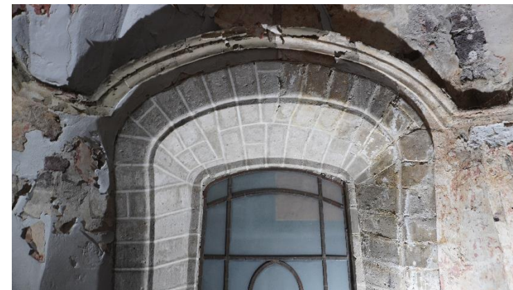
Figura 65. Estado Inicial de Cúpula Principal.
