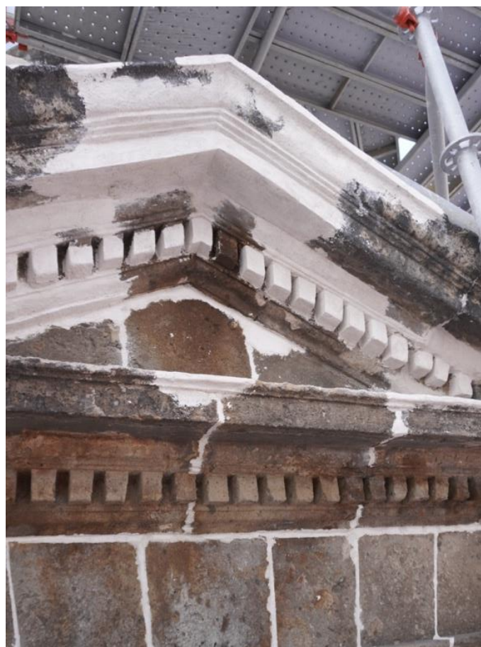
Figura 92. Proceso de intervención en elementos de cantera en torres campanario
