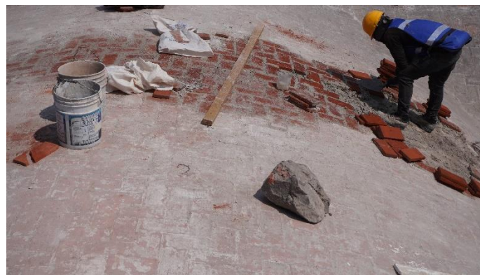
Figura 9. Reintegración de enladrillado.
