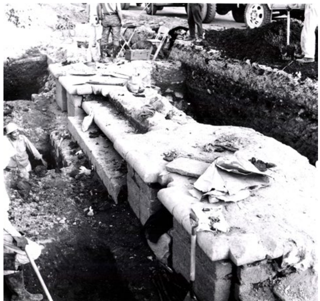
Hallazgo durante la construcción de la Línea 1 del Metro. Foto: Colección Carlos Villasana.
